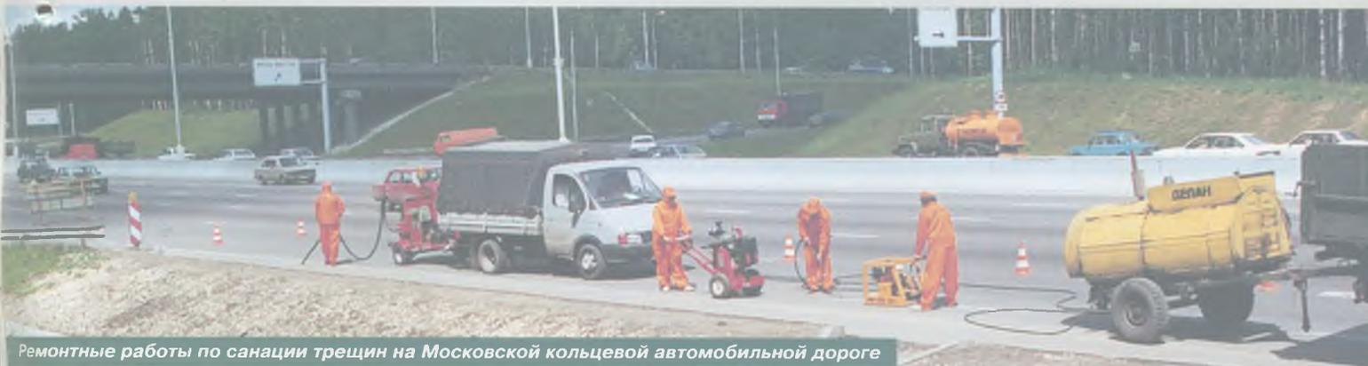
Ремонтные работы по санации трещин на Московской кольцевой автомобильной дороге
