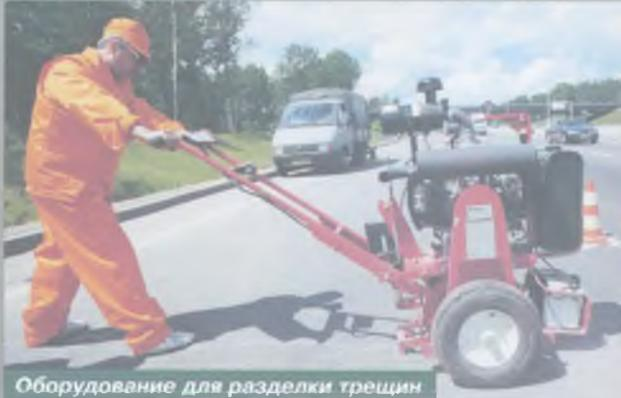
Оборудование для разделки трещин
