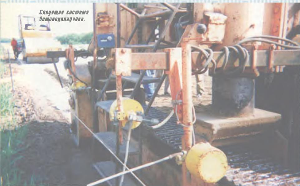
Следящая система бетоноукладчика.
