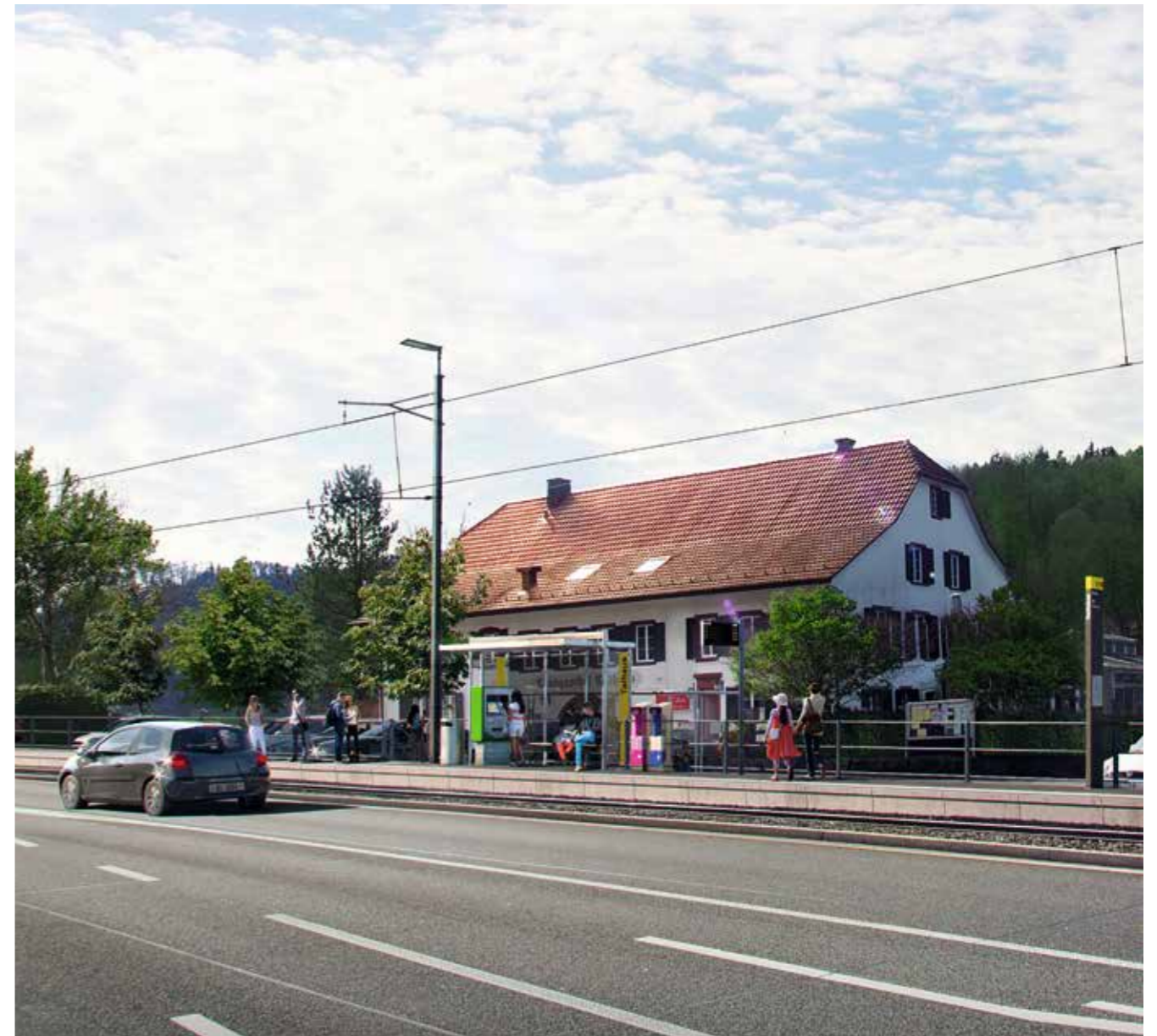
Das «Erneuerungsprojekt Waldenburgerbahn» startete am 22. Mai 2018 mit dem Spatenstich zur neuen Haltestelle «Talhaus».
