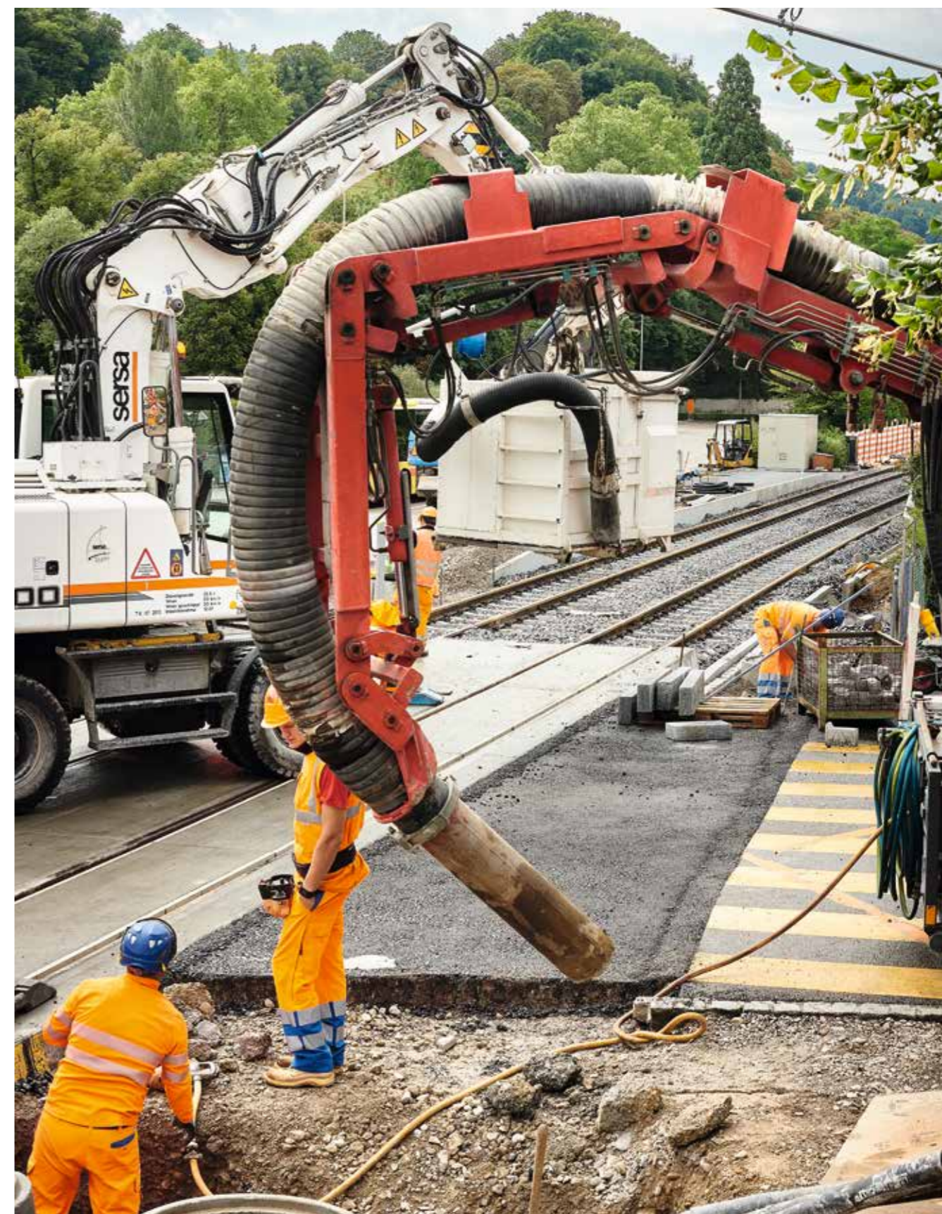
Auf vier Abschnitten der Linie 10 im Birstal wurde die Infrastruktur komplett erneuert, hier die Haltestelle «Hofmatt».
