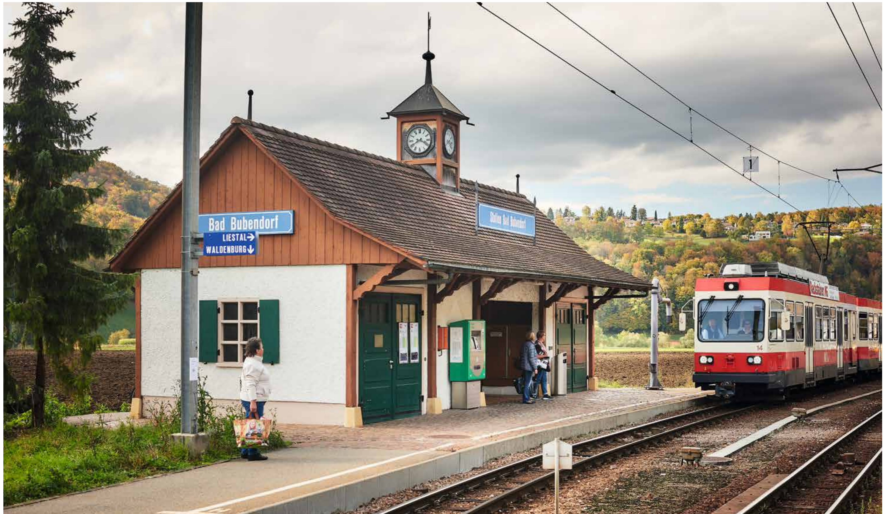
Im Rahmen des «Erneuerungsprojekts Waldenburgerbahn» wird bei der neuen Haltestelle «Bubendorf» ein 270 Meter langer Doppelspurabschnitt erstellt. Diese Kreuzungsstelle erhöht die Anschlusssicherheit beim Bahnhof Liestal.
