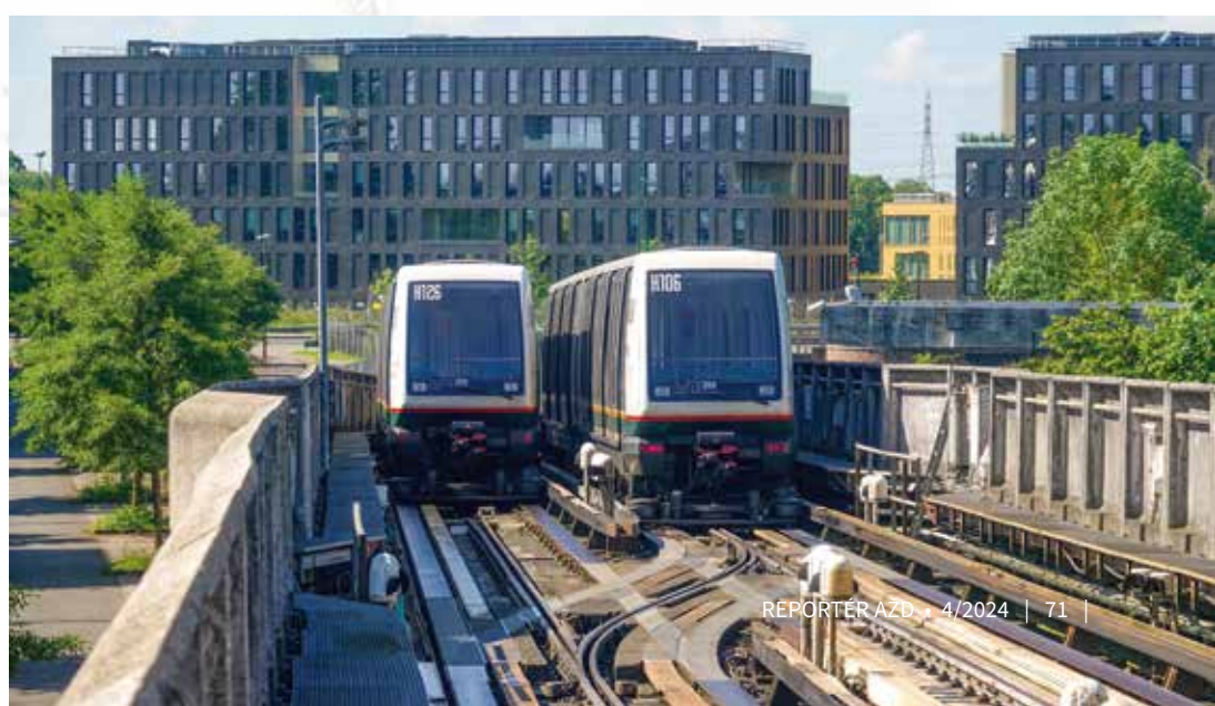
→ Záběr na speciálně konstruované automatické metro VAL v Lille v jeho nadzemním úseku u konečné stanice Quatre Cantons
