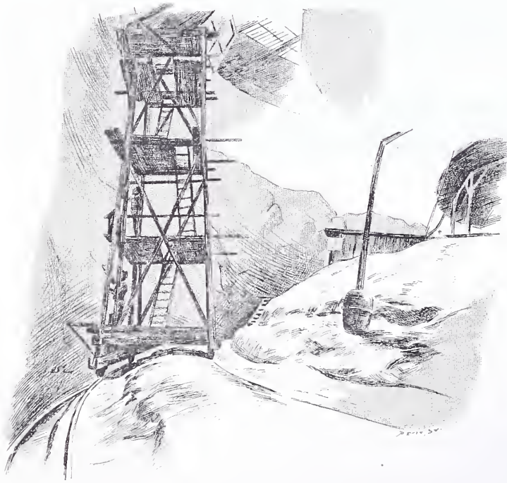
1° Un échafaudage sur les rails.
