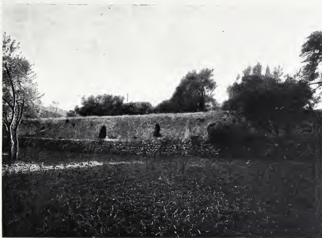
FIG. 6 — DINTORNI DI CANDIA — CONDUTTURE DELL'ACQUEDOTTO.
