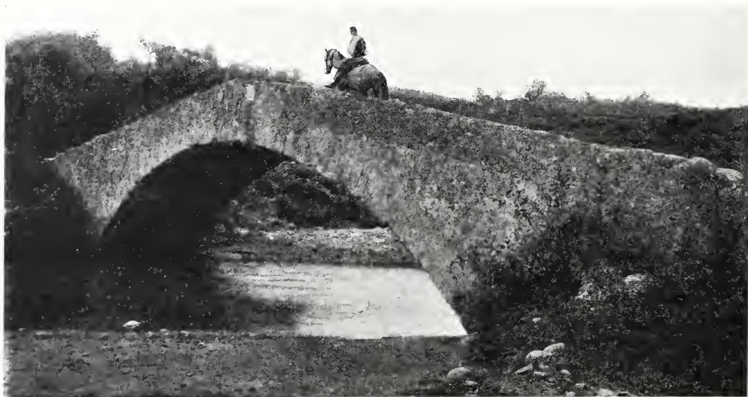
FIG. 57 — S. MARCO — PONTE DEL 1582 (565).
