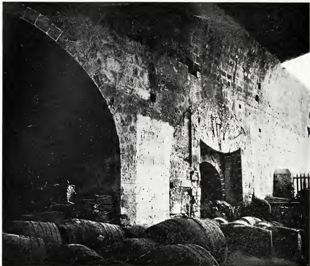
FIG. 78 — CANDIA — INTERNO DEGLI ARSENALI VECCHI (142).
