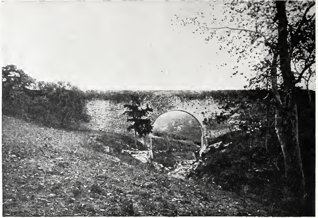
FIG. 7 — * SÍLAMOS (DINTORNI) — PONTE DELL'ACQUEDOTTO (697).
