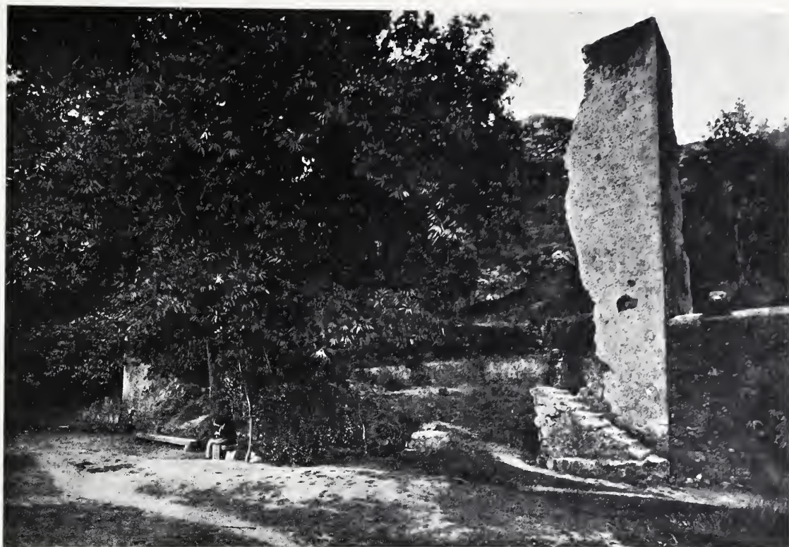
FIG. 13 — DINTORNI DI CANEA — L'ORIGINE DELL'ACQUEDOTTO (461).
