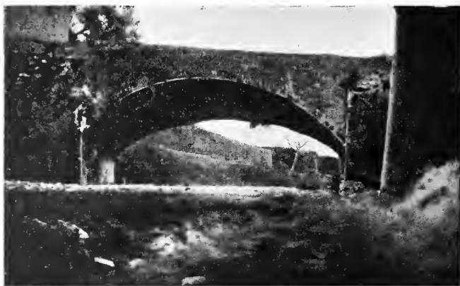
FIG. 14 — DINTORNI DI CANEA — PONTICELLO DELL'ACQUEDOTTO.
