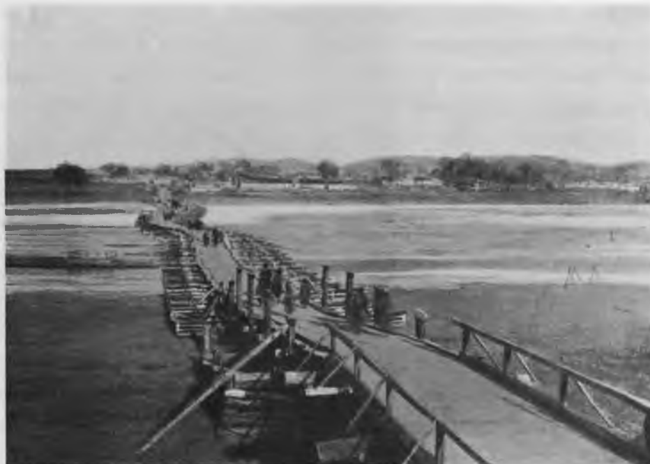
Ледоходъ при содержаніи моста.
