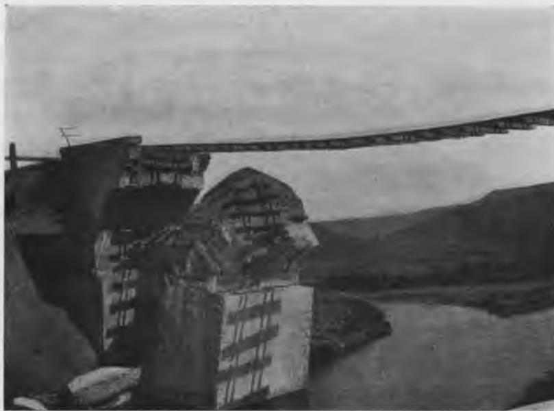
Наводненіе. Размытъ желѣзнодорожный мостъ.
