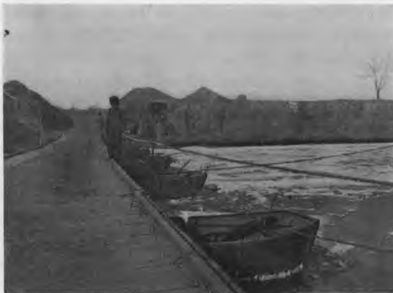
Понтонный мостъ между дер. Эльхтайцзы.
