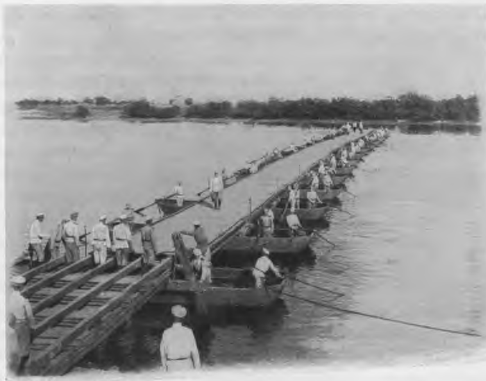
Постройка понтоннаго моста черезъ р. Тайцзыхе.
