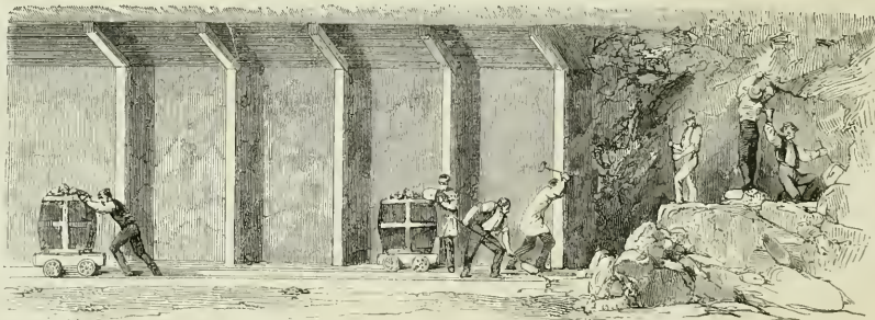
Percement de la galerie supérieure dans les marnes sèches du lias.
