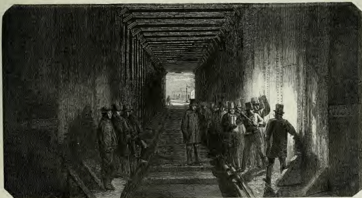
Intérieur du pont-tube Britannia. M. Stephenson posant le deux millionième et dernier rivet.
