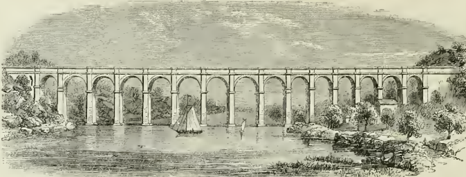
Aqueduc sur la rivière de Harlem.
