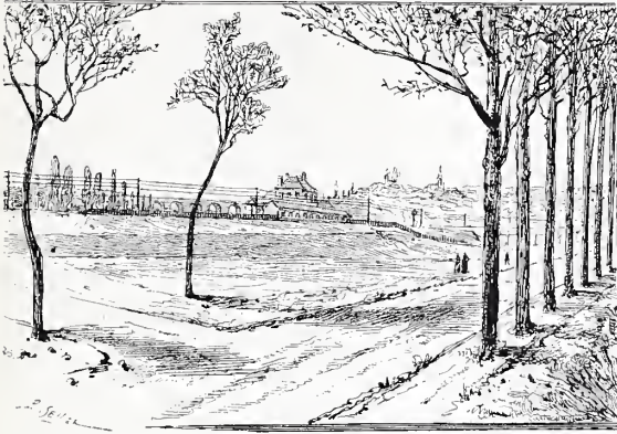
FIG. 10. — La gare des Moulineaux, côté de la Seine.
