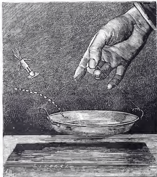
Un plat à frire transformé en électrophore.
