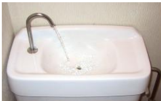
Ein Hahn auf dem Wasserkasten hilft beim Wasser- und Platzsparen.
