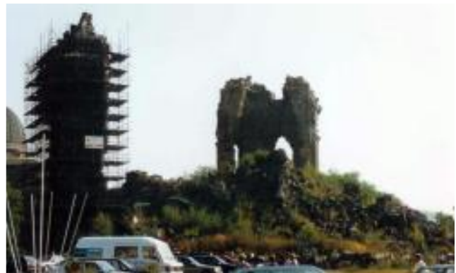
Die Ruine ist im Sommer 1991 schon teilweise eingestürzt (Foto: Heinrich Gimmler)
