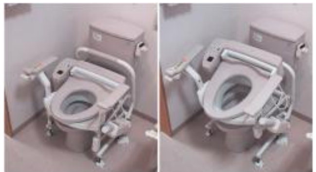
Funktionsklo mit Aufstehhilfe (Foto: Chris)
