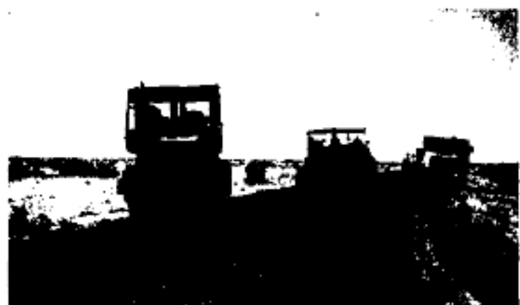
Строительство дорог в Жанакорганском районе
