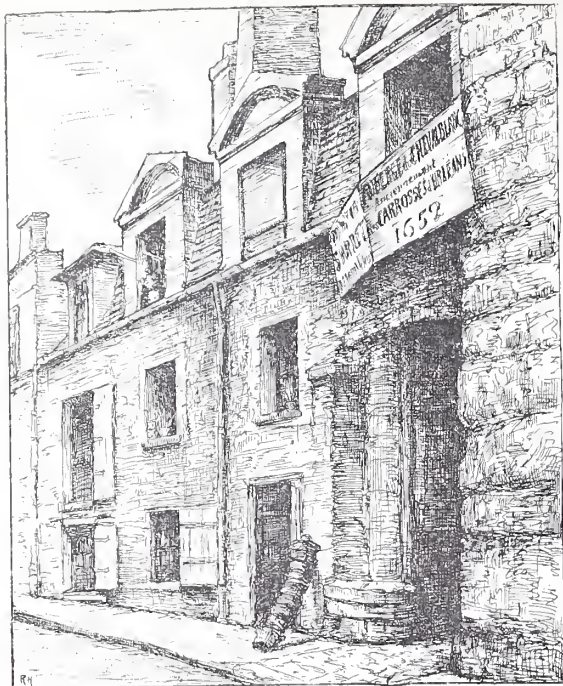
AUBERGE DU CHEVAL BLANC. — Façade rue Mazet.
