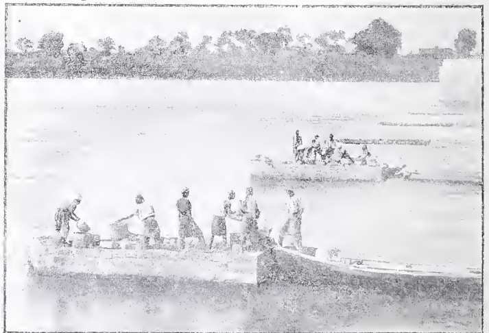
Construction des piles du pont de Mahina sur le Bafing.
