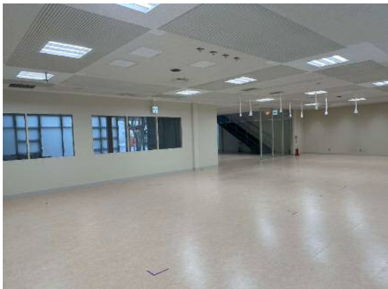
(1) 大学 12 号館改修工事
