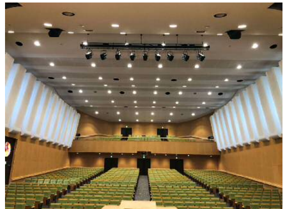
(2) 六浦中学校・高等学校 講堂特定天井耐震改修工事
