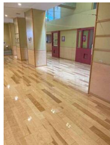
(4) 六浦こども園 2 階保育室他床面コーティング工事
