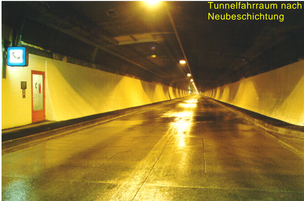
Bild 8: Tunnel nach erfolgter Sanierung
