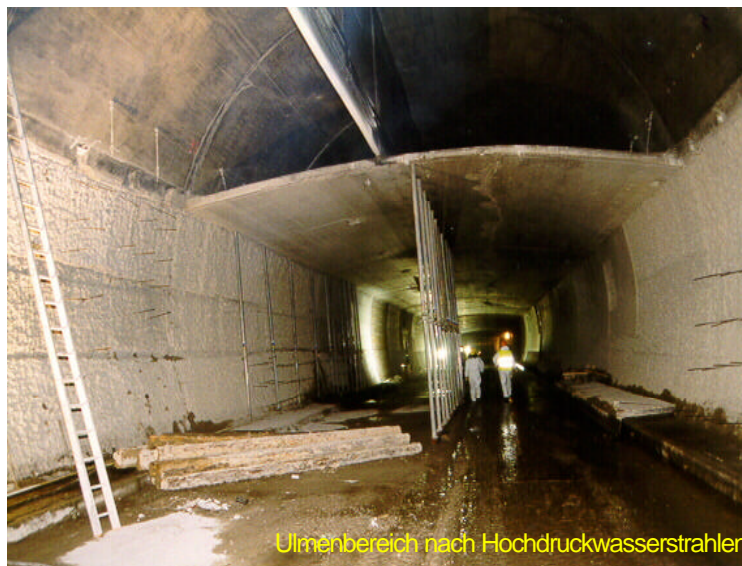
Bild 7: Sanierung der Brandstelle
