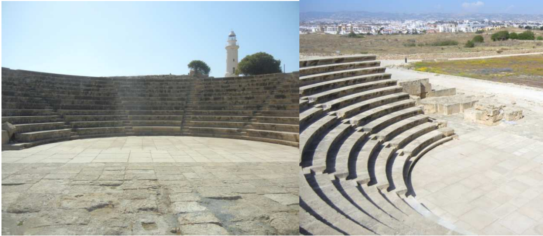
Vistas del odeón de Pafos restaurado (fotos Arfuch)
