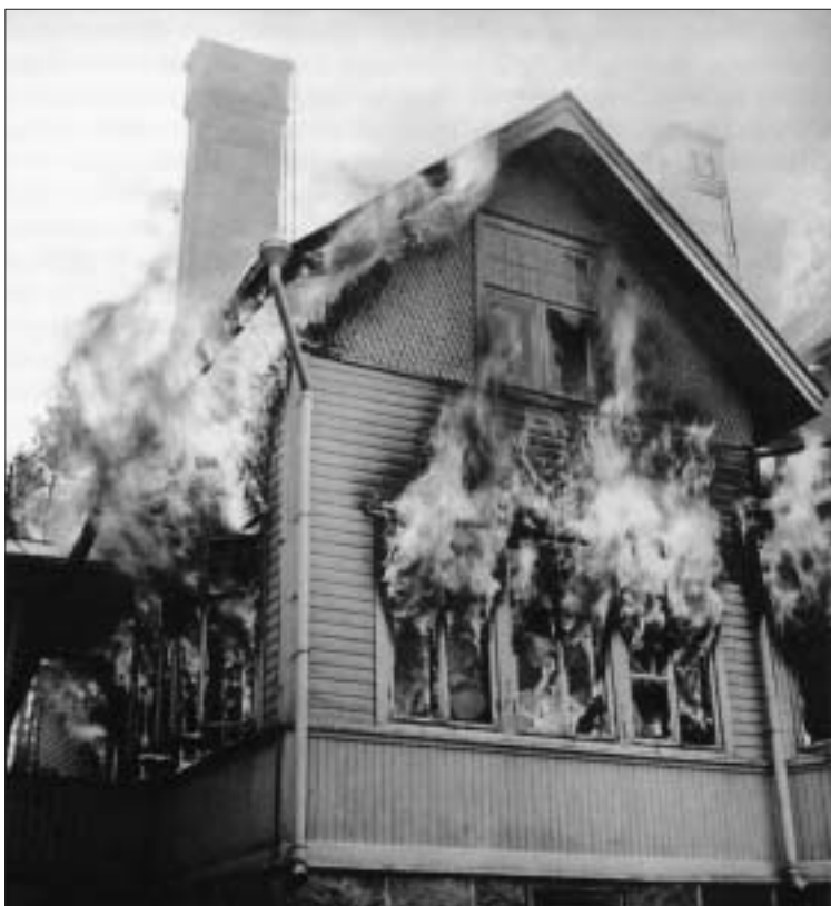
Talo palaa Helsingin Tapanilassa 25.6.1941 neuvostopommittajan hyökkäyksen jälkeen. Jälleenrakennusta turvanneet Sotavahinkoyhdistykset saivat korvausurakkansa valmiiksi vuosikymmenen loppuun mennessä. Niitä seurannut Sotavahinkoyhdistyksen säätiö tulisi jatkossa tukemaan maan henkistä rakentamista sekä osallistumaan moniarvoisen demokratiamme puolustamiseen. Teoksen kuvitusta (SA-Kuva).
