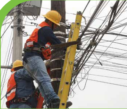
Diariamente se retiran 7 mil metros lineales de cables en desusos.
