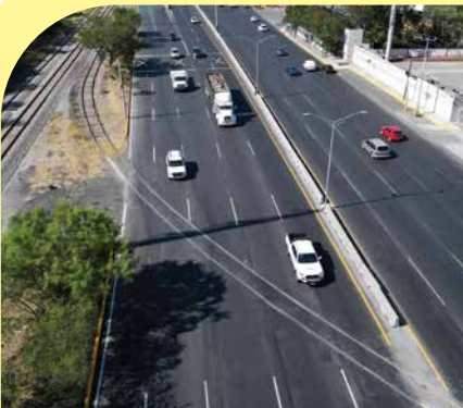
Reconstrucción de Av. Manuel L. Barragán
