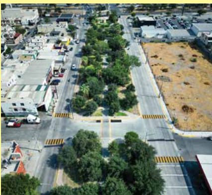
Reconstrucción de Av. República Mexicana con concreto hidráulico
