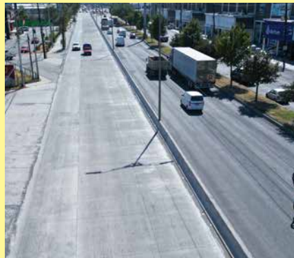
Reconstrucción de Av. López Mateos con concreto hidráulico
