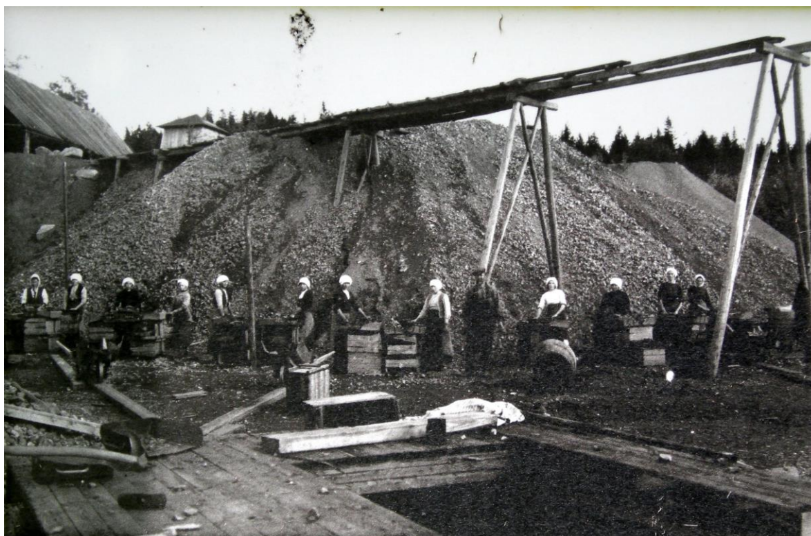
Figur 2. Skrädplats nedan varphögen invid ett schakt; okänd gruva i Bergslagen, tidigt 1900-tal. Fotograf: okänd.
