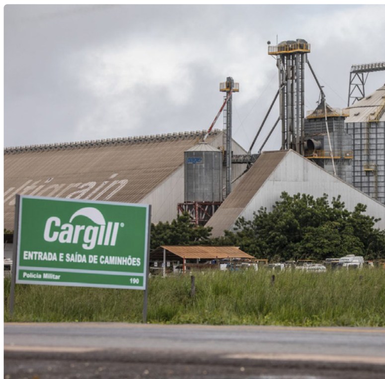
Centro de distribuição da multinacional Cargill no oeste baiano
