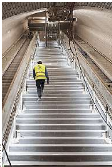
La station Porte-de-Clichy, sur la ligne 14, doit ouvrir ce mois-ci.
