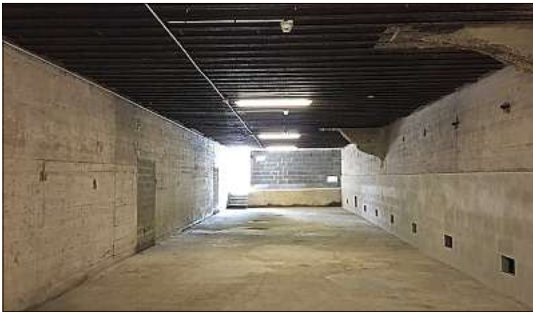
Le bunker de Saint-Malo (Ille-et-Vilaine) s'étend sur une surface de 340 m 2 .
