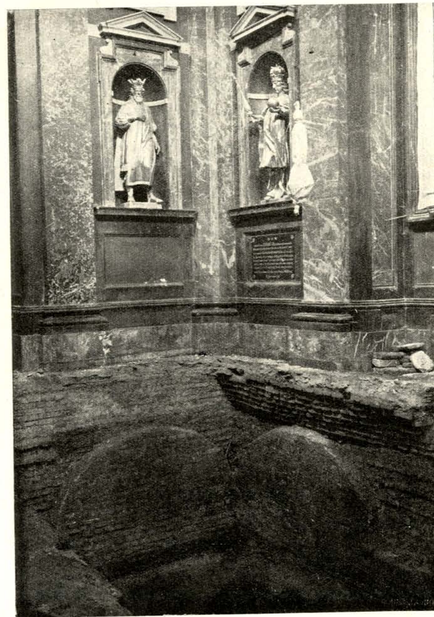
Kaplica św. Kazimierza z odsłoniętymi od wewnątrz fundamentami.
