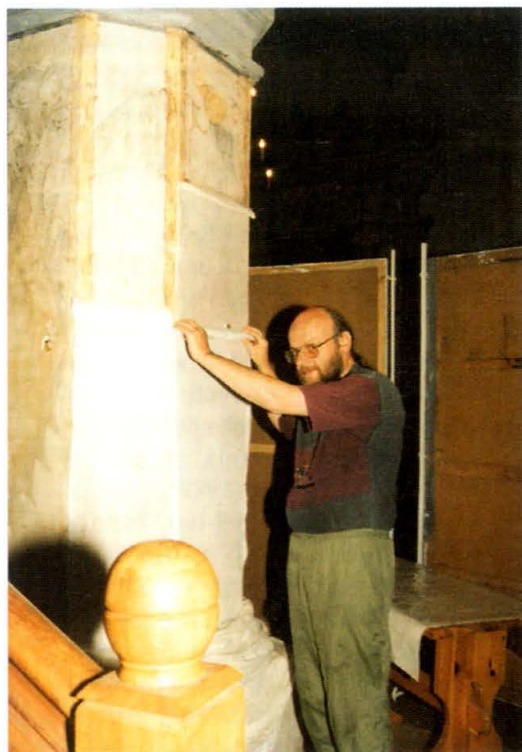
3. Filar pld.-wsch. w trakcie zakładania kolejnych warstw facygu. Stan podczas konserwacji. South-eastern pillar during the placing of successive layers of facing. State during conservation.
