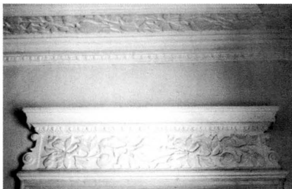
15. Wnętrze salonu – zwieńczenie drzwi i fragment bordiury sufitu.
