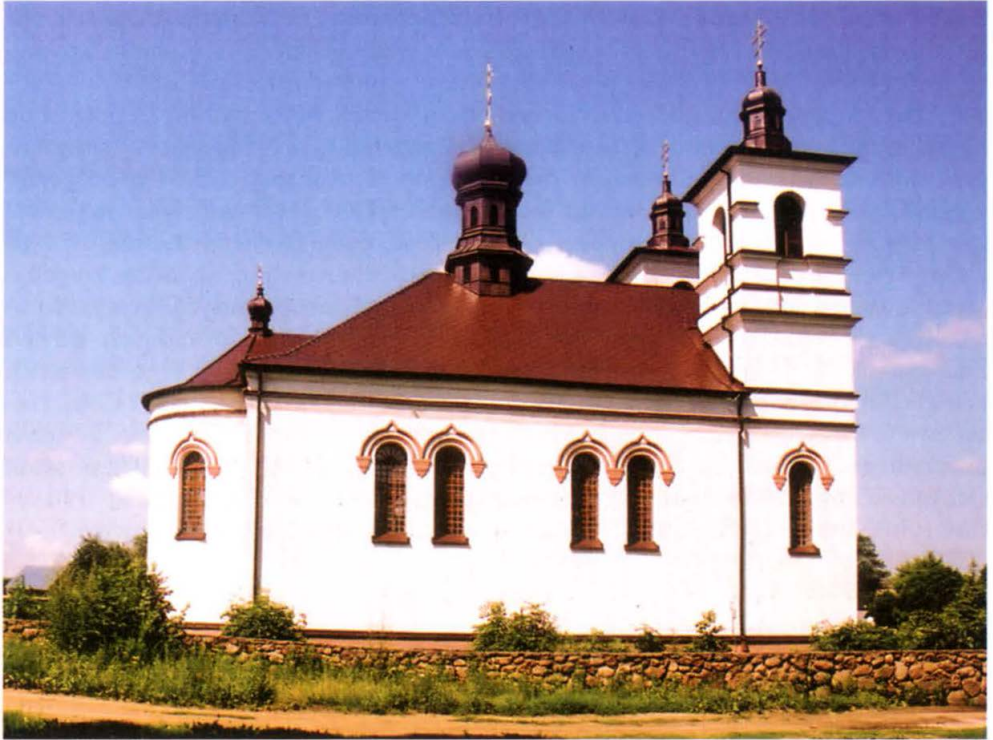
6. Widok na elewację boczną, stan 2003.
