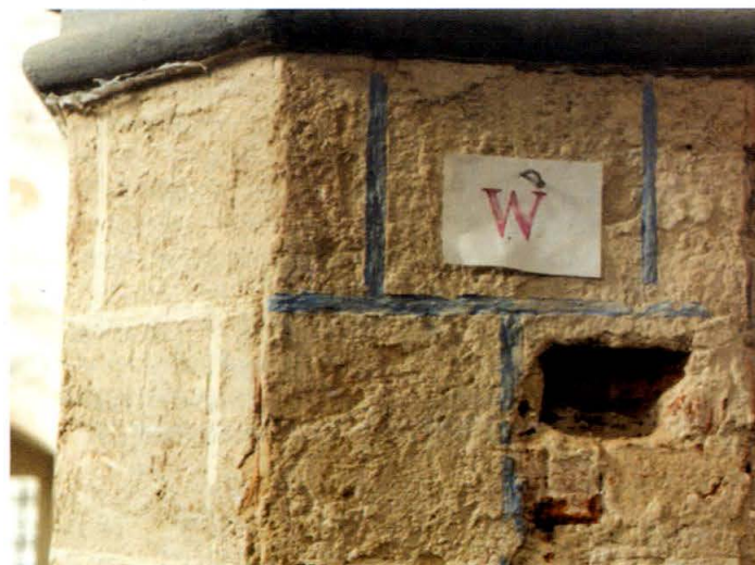
7. Południowo-wschodnia i wschodnia ścianka filara pld.-zach. z odsłoniętymi kolorowymi śladami po boniowaniu. Stan podczas konserwacji. South-eastern and eastern wall of the south-western pillar with uncovered colour traces of rustication. State during conservation.
