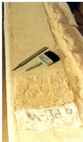
8. Odwrocie ścianki południowo-zachodniej z pld.-wsch. filara w trakcie usuwania starego, rozluźnionego tynku; pozostawione ślady boniowania. Stan podczas konserwacji. Reversal of south-western wall from the south-eastern pillar in the course of the removal of the old loose plaster - traces of rustication. State during conservation.
