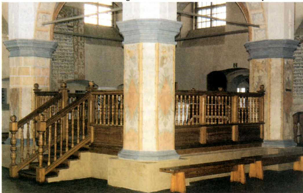
15. Filary bimy po konserwacji. Na pld.-zach. filarze (z lewej) fragment zrekonstruowanego boniowania z XVII w. Tebam pillars after conservation. The south-western pillar (on the left) shows a fragment of reconstructed seventeenth-century rustication.
