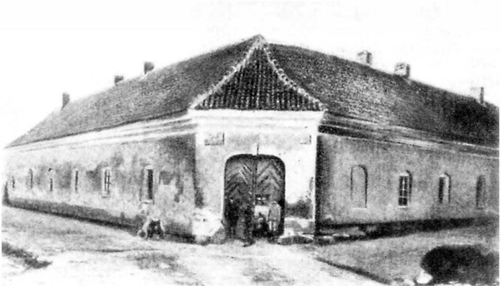
9. Widok alumnatu w Tykocinie ok. 1900 r. Alumnat jeszcze przed rozwiązaniem jego pierwotnej funkcji – przytułku dla żołnierzy weteranów i inwalidów. Widoczne inne, niż obecnie – kształt dachu oraz forma okien [wg: Z. Gloger, Encyklopedia Staropolska Ilustrowana , Warszawa 1900 r., T. I, s. 42]. View of the shelter in Tykocin, about 1900 before the elimination of its original function – a home for veterans and war invalids. The different shape of the roof and form of the windows differ from the present-day ones (acc. to Z. Gloger, Encyklopedia Staropolska Ilustrowana [Illustrated Old Polish Encyclopaedia], Warszawa 1900, vol. I, p. 42)
