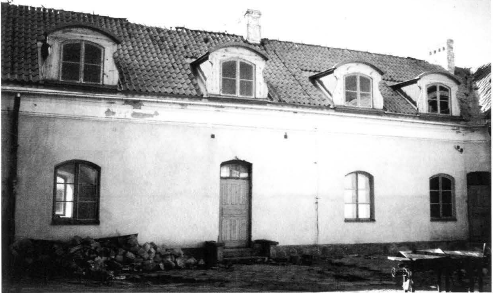
26. Tykocin. Alumnat wojskowy – elewacja wschodnia od strony dziedzińca. Lukarny wprowadzono we wszystkich skrzydłach obiektu podczas ostatnich prac remontowo-adaptacyjnych. Fot. S. Wicher, marzec 2000.
