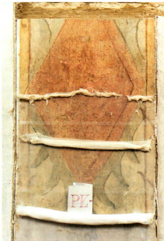
12. Filar pld.-wsch., ścianka południowa podczas usuwania facingu. Stan podczas konserwacji. South-eastern pillar – southern wall during the removal of the facing. State during conservation.
