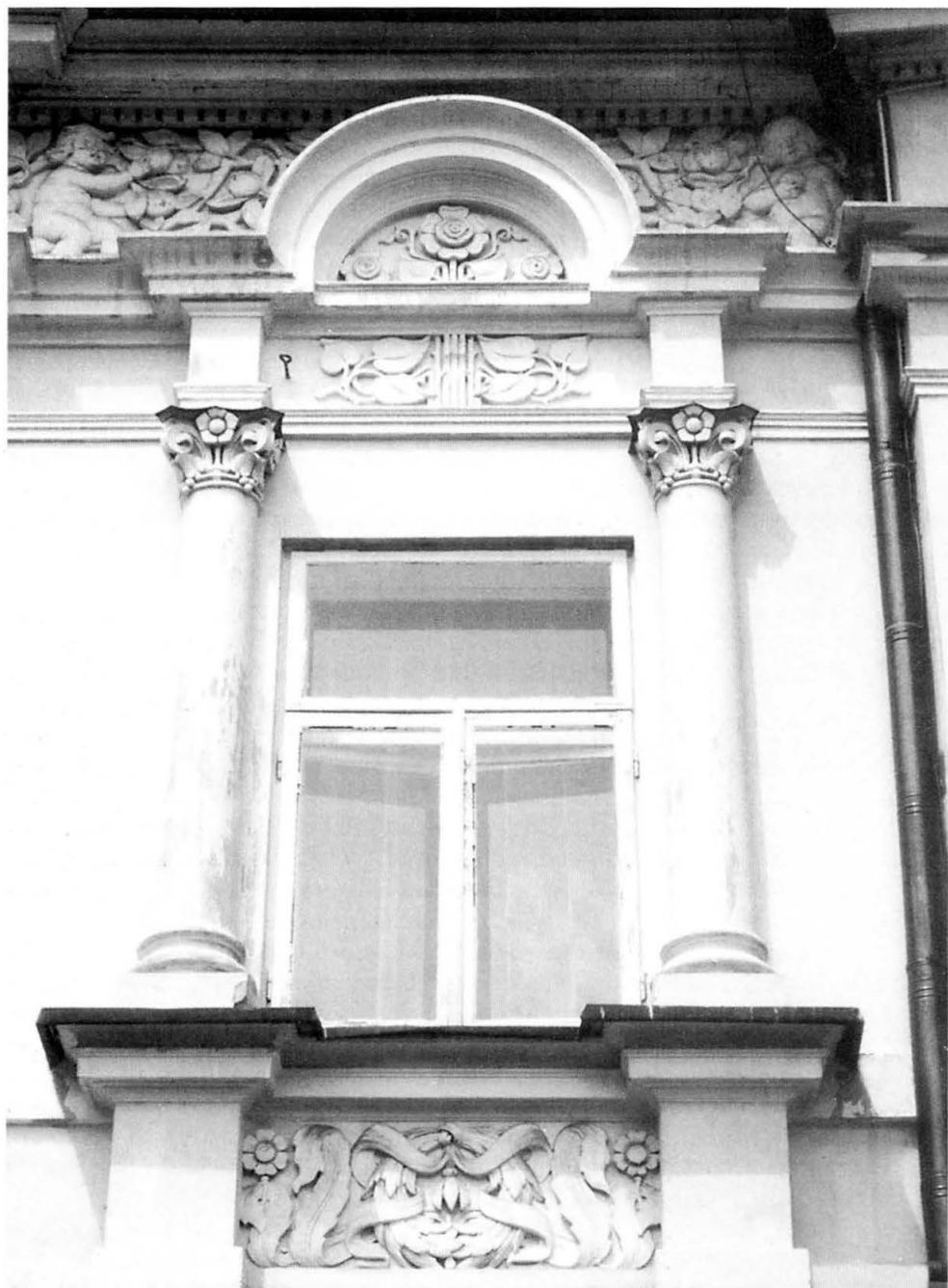
1. Pałac Buchholtzów w Supraślu. Obrazowanie okna w elewacji frontowej. (Wszystkie fot. Małgorzata Dolistowska, 2002 r.) The Buchholtz Palace in Supraśl. Window setting in the front elevation. (All photos: Małgorzata Dolistowska, 2002)
