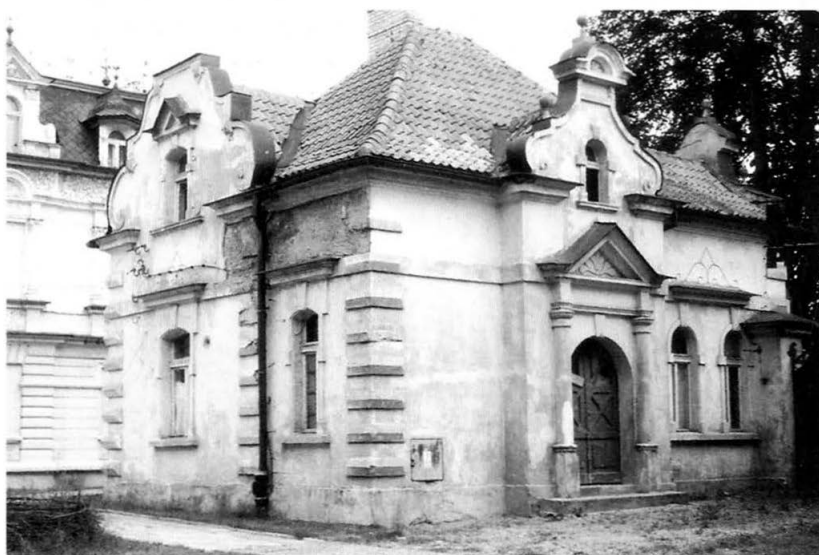
21. Stróżówka przy pałacu, widok od strony wozowni. Lodge, view from coach house.
