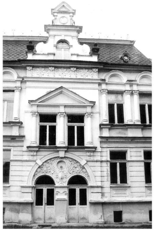
5. Ryzalit klatki schodowej i wejście do skrzydła bocznego. Staircase projection and entrance to the side wing.
