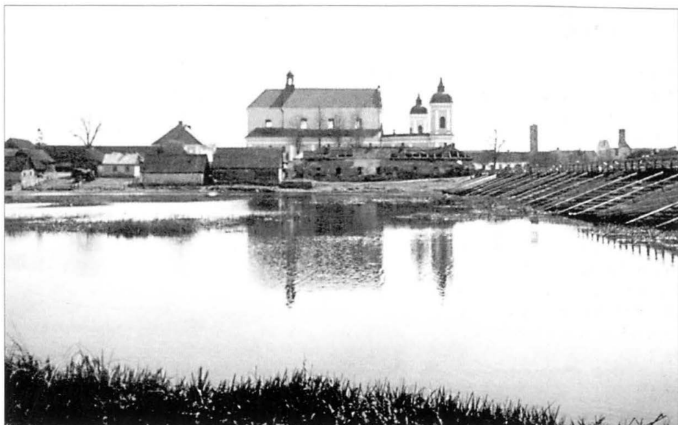
10. Tykocin. Widok kościoła pomisjonarskiego (ob. paraf. pw. Przenajświętszej Trójcy) i alumnatu z przeciwnej strony Narwi w kierunku południowym.
