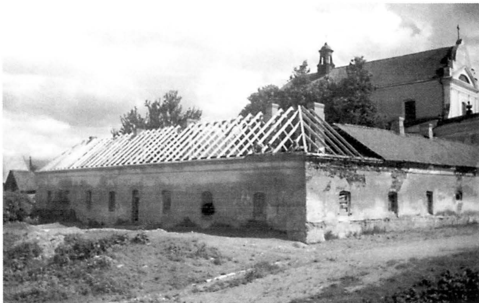
16. Tykocin. Alumnat wojskowy. Widok od strony północno-zachodniej, w głębi fragment kościoła pw. Przenajświętszej Trójcy. Alumnat w trakcie wymiany więźby dachowej, której kształt miał nawiązywać do formy dachu sprzed 1914 roku. Widoczne podwyższenie kalenicy dachu w stosunku do poprzedniego jej poziomu. Fot. W. Paszkowski 1957 r. [neg. WO SOZ Białystok, sygn. M/14/1191/5].
