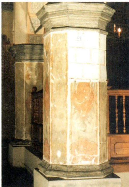
13. Filar pld.-zach. od strony południowej po uzupełnieniu ubytków tynku kitem. Stan podczas konserwacji. South-western pillar from the south side after the supplementation of the missing plaster with putty. State during conservation.
