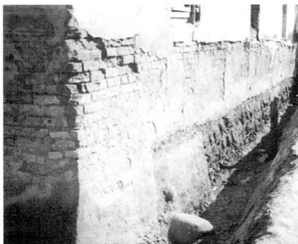
17. Tykocin. Alumnat wojskowy. Narożnik północno-zachodni i część elewacji zachodniej. Widoczny fragment muru i część odsłoniętego fundamentu dawnych baszt, podczas osuszania prowadzonego w trakcie prac konserwatorskich z lat 1957-1959. Fot. W. Paszkowski 1958 r. [neg. WO SOZ Białystok, sygn. M/15/1280/2] Tykocin. Veterans' home. North-western corner and part of the western elevation. Visible fragment of wall and part of the disclosed foundation of former bastions in the course of draining conducted as part of conservation in 1957-1959. Photo: W. Paszkowski 1958 (neg. WO SOZ Białystok, call no. M/15/1280/2)
