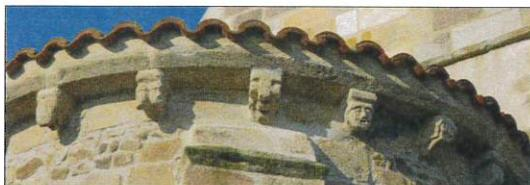
Extérieurement le chœur possède en partie supérieure une corniche supportant la couverture. Celle-ci est soutenue par des modillons sculptés.
