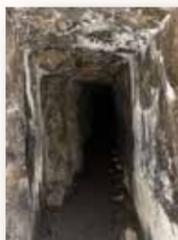
1. 西野水道: 賤ヶ岳(しづがたけ)の南に位置する西山から、琵琶湖へ向かって山腹をくり貫いてつくられた排水トンネル。江戸後期、たびたび洪水に見舞われていた西野村(現・長浜市高月町)を水から守るため、村人が私財を投じて実施。洪水によって溜まった水を排水する効果的な手段は当時なく、トンネルによって琵琶湖への排水経路を確保することは村人の長年の悲願であった。能登、伊勢から石工を招き、6年の歳月と1,275両(現在の価値にして5億円)をかけ、手作業で固い岩盤が掘り貫かれた。高さ約2m、幅約1.2m、長さ約220m。
