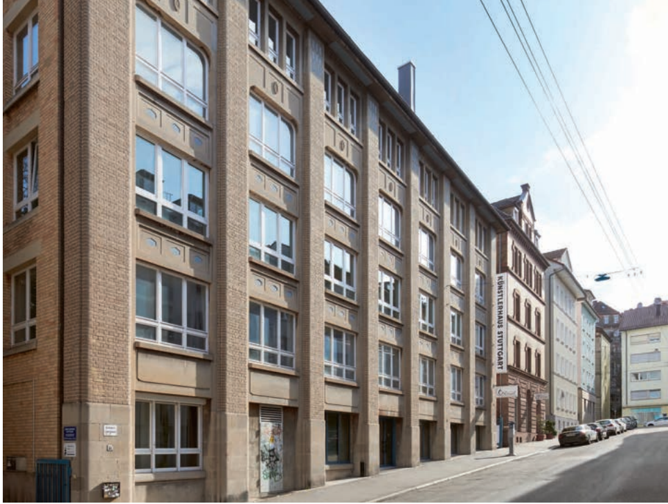
Abb. 15 Fassade Künstler- haus Stuttgart, 2019
