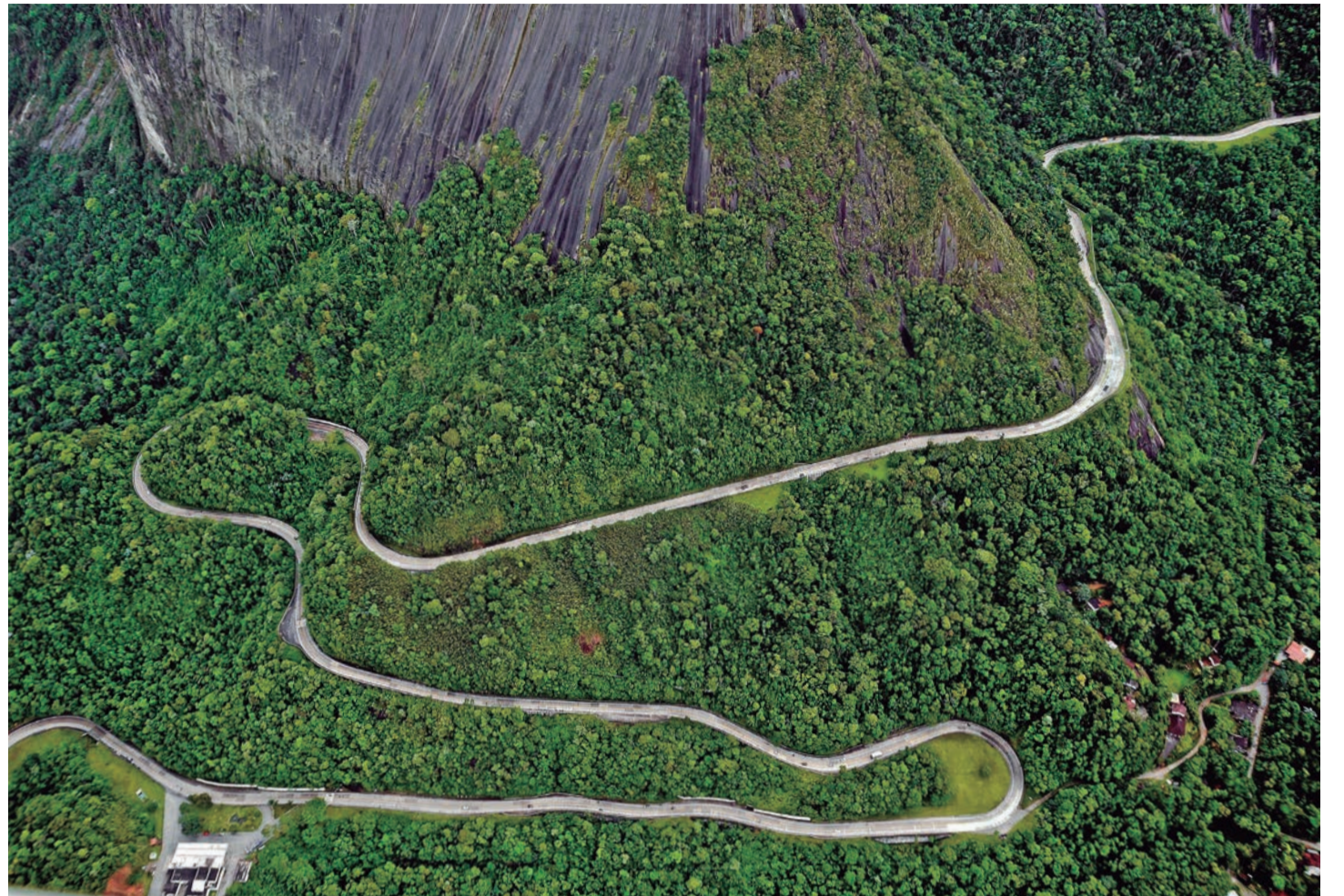
Trecho de serra da Rodovia Rio-Teresópolis (BR-116): a maioria das vias em serras brasileiras não foi objeto de um projeto estruturado
