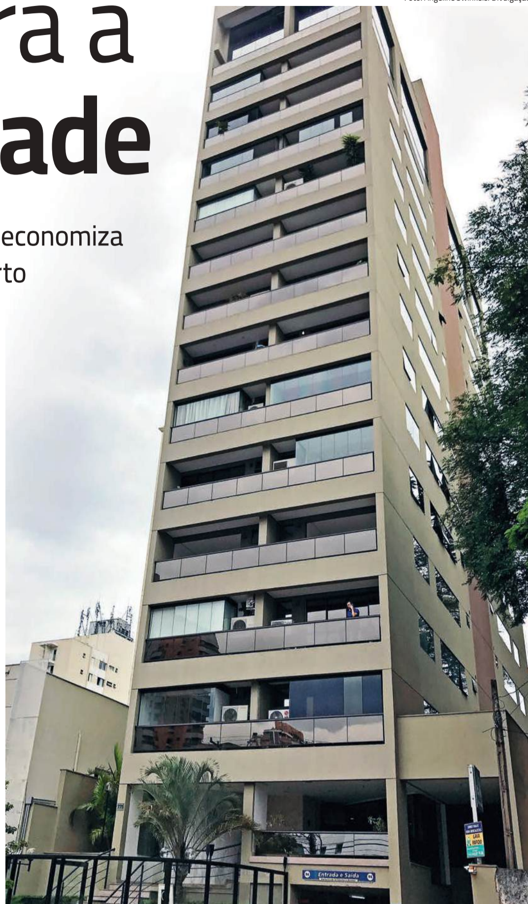
Edifício de escritórios com varandas: base de dados contém principais características de prédios com sistemas mistos de climatização
