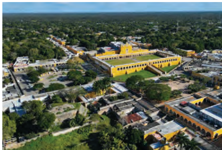
EX CONVENTO DE SAN ANTONIO DE PADUA, VISTA AÉREA.
