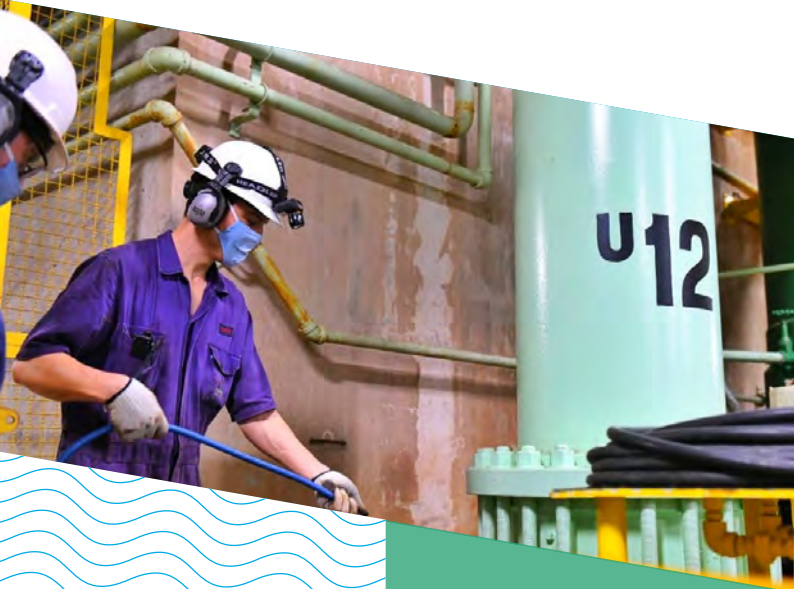
图片：位于巴西和巴拉圭之间的伊泰普水电站的工程师持续维护运行，同时严格实施新冠病毒疫情下新的健康和安全的准则。 图片来源：I tai pu Bi naci onal 伊泰普水电站。
