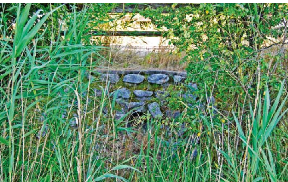
31/2: Einlaufbauwerk des Grabens A Richtung Östliche Wörthenlacke (10. Juli 2010)
