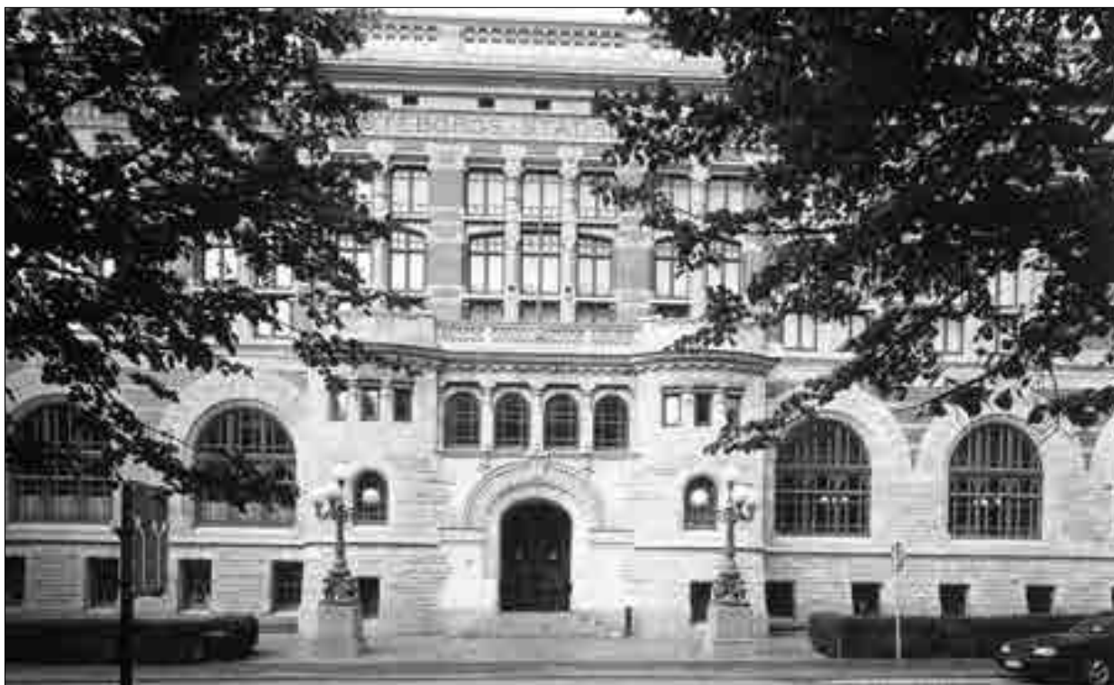
Gamla Stadsbiblioteket, entréfasaden mot Vasagatan.
