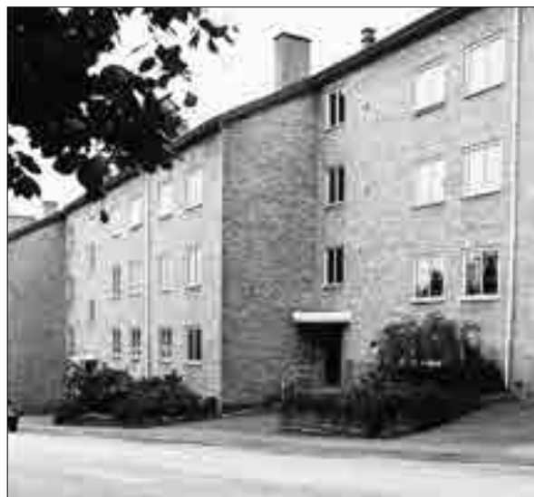
Kv 39, fasad mot Fridkullagatan.
