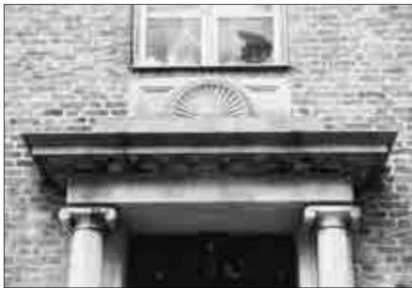
Entré med naturstensportal, Teknologgatan.
