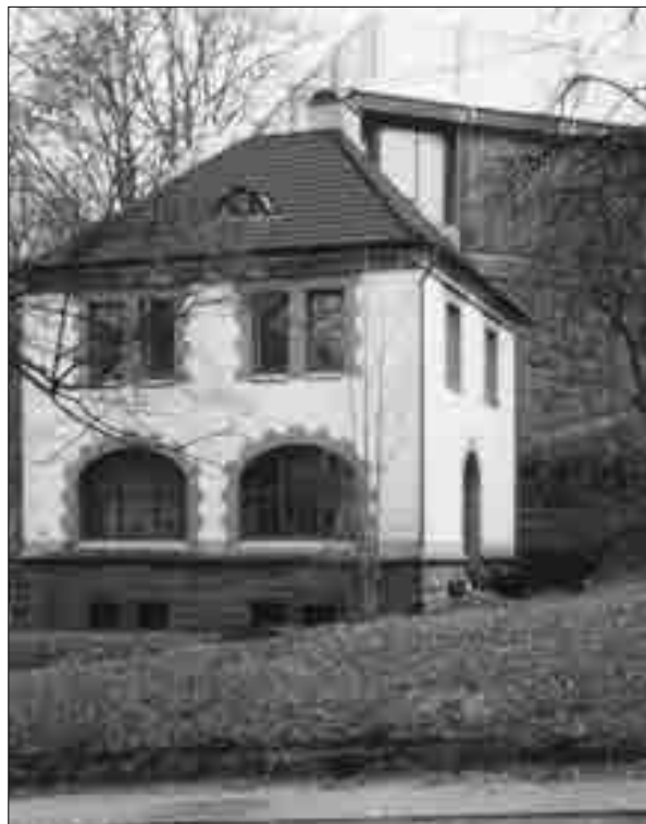
F d pumpstation och reservoar.
