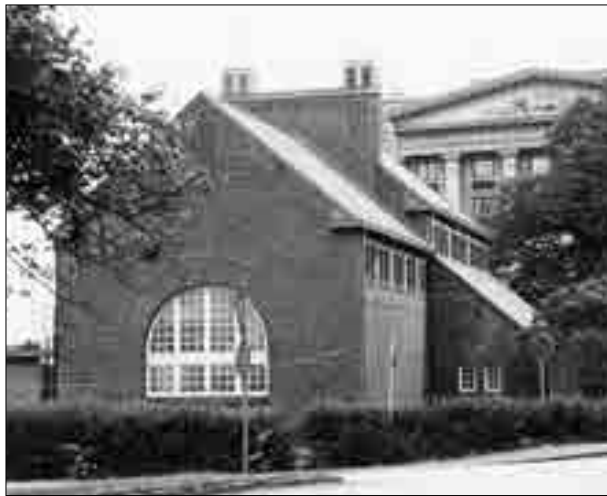
F d Pumpstationen. I bakgrunden Amerikabuset.
