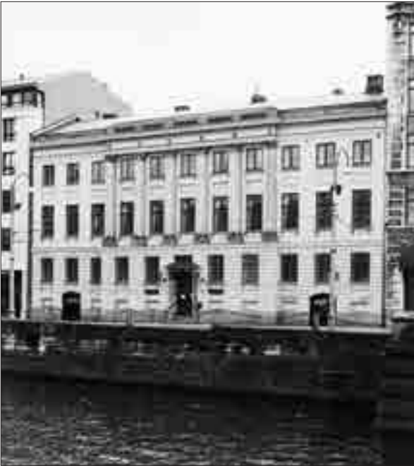
Chalmerska huset, Södra Hamngatan 11.
