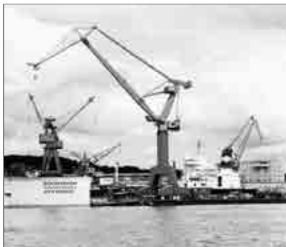
Götaverken/Cityvarvet etablerades på Hisingen 1867 och var i början av 1900-talet det största av älvstrandens tre varv. Det är värdefullt från industribeskrivningssynpunkt och har ett högt traditions- och symbolvärde. (Ingår i Norra Älvstranden – Kulturmiljön 1989.)
