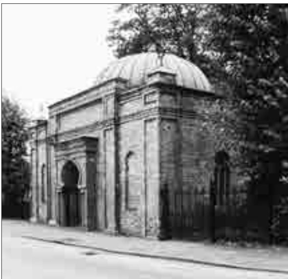
Mosaiska begravningskapellet, fasad mot Friggagatan.
