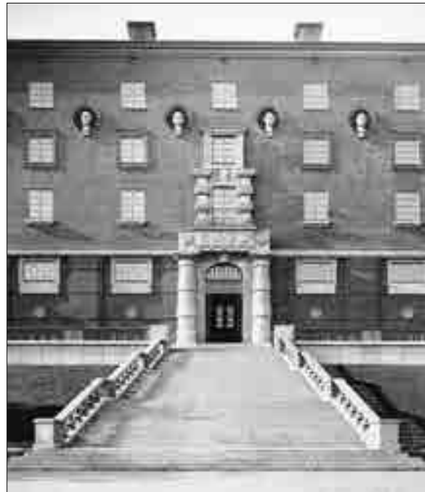
Chalmers. Den ursprungliga huvudbyggnadens östfasad med stora uppgången. Foto från 1920-talets slut.
