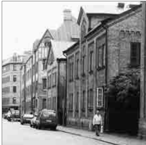
Kvarteren 7, 6 och 5. Fasader mot Haga Östergata.
