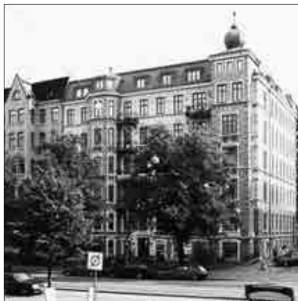
Till höger Linnégatan 50, kv 2:10. Till vänster Linnégatan 48, kv 2:11 med hel fasad av kalksten.
