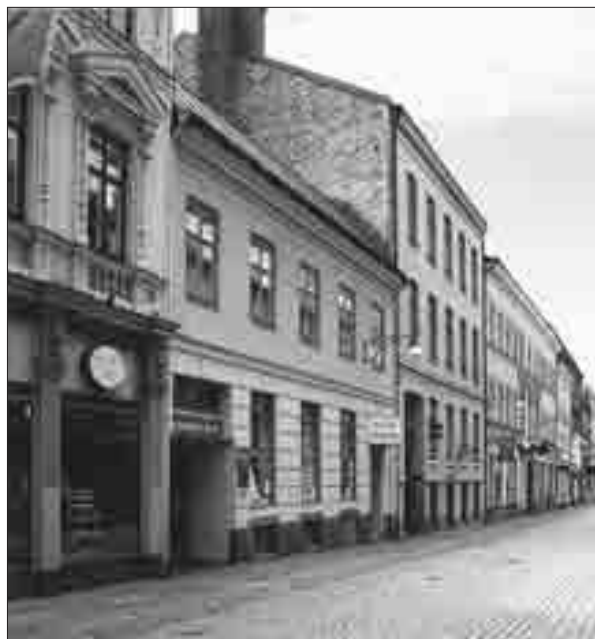
Vallgatan 25–21, uppförda 1806, 1878 och 1815.
