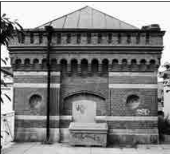
F d pumpstation, norra byggnaden.
