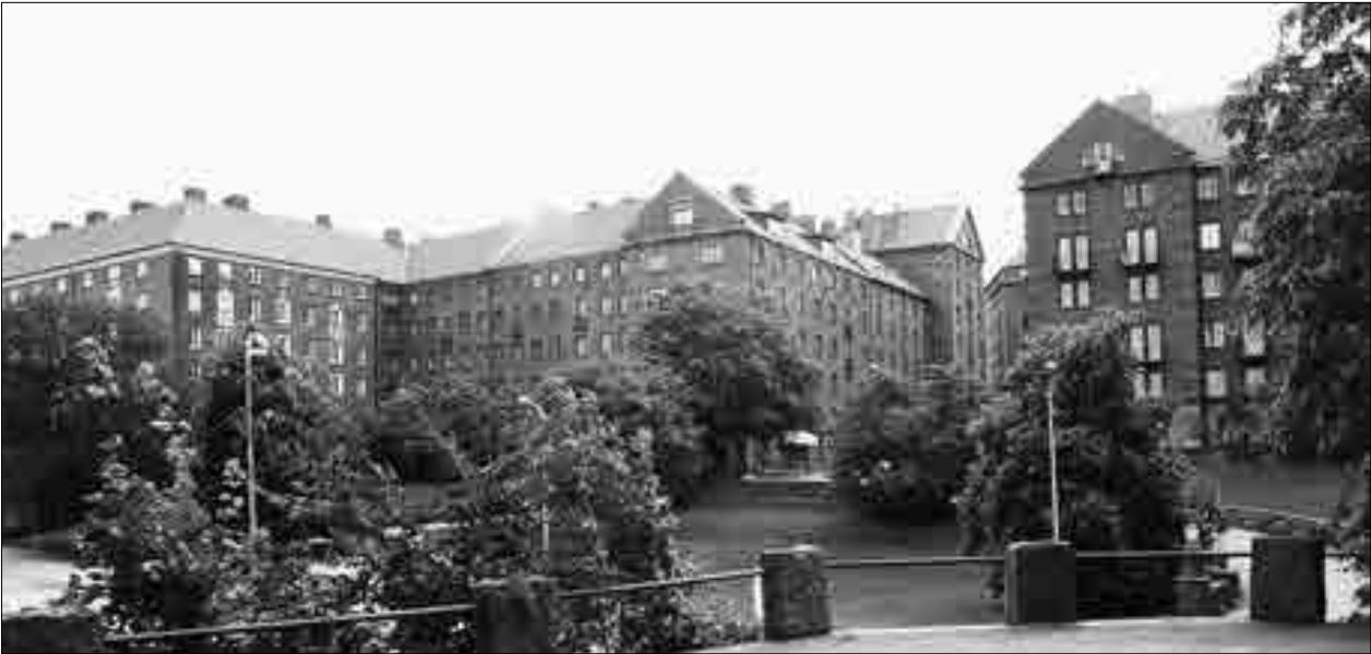
Terrassgatan sedd från f d Handelsinstitutets entréplan.
