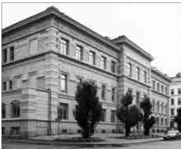
F d Chalmers, entréfasad Storgatan 43.
