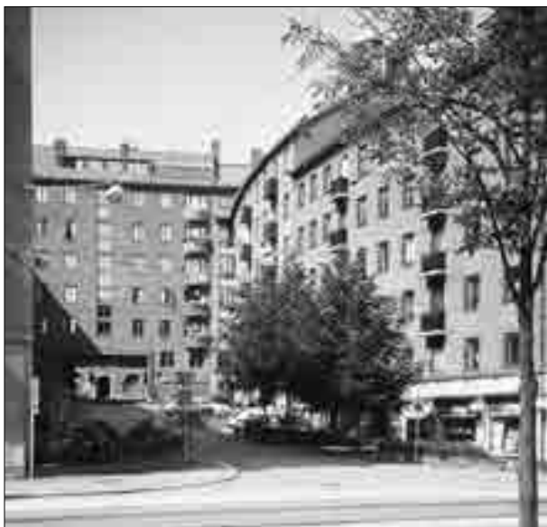
Kv 14 Stenskvättan, Cederbourgsgatan och valvet mot Eklandagatan.
