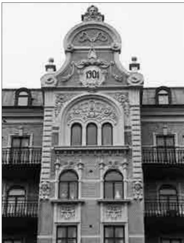
Linnégatan 27, kv 15:3. Efter renovering 1998.
