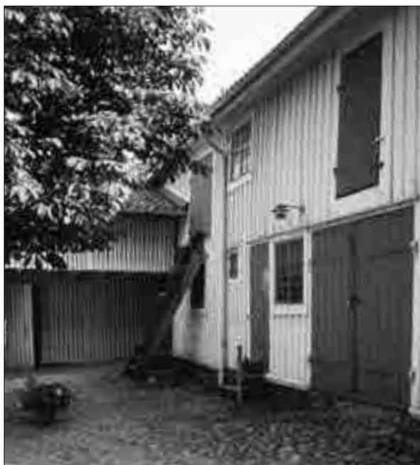
Kv 20, Skolgatan 36. Gärd med bevarat stall och dass.
