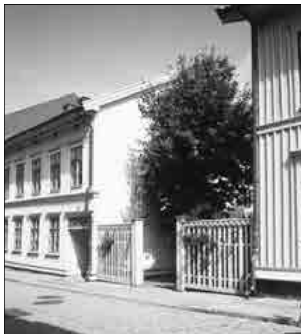
Kv 21, Husargatan 44–46. Gärdsentréerna.
