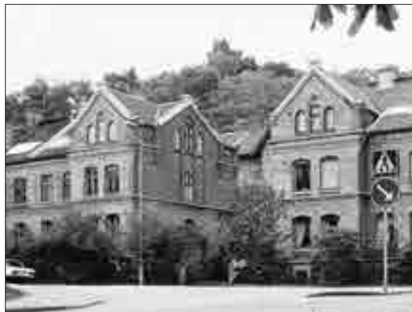
"Göteborgs Arbetarebostads AB", kv 5:11–12
