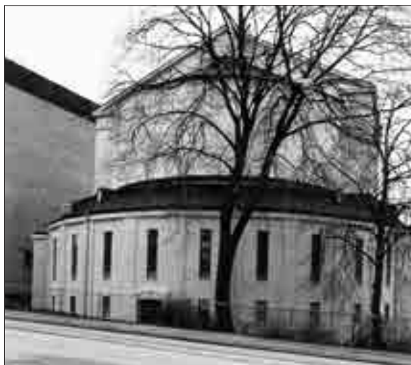
Lorensbergsteatern, fasad mot Berzeliigatan.
