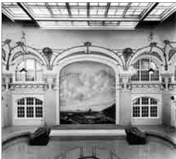
Renströmska badet, den restaurerade simhallen.
