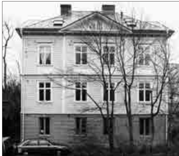
Södra Viktoriagatan 27, kv 11:9.
