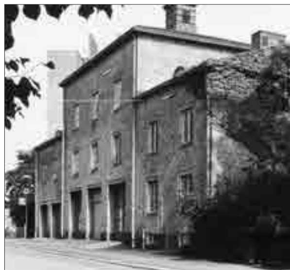
F d Hedens brandstation.
