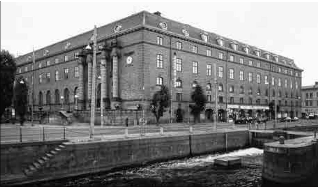
Centralposten, sydvästra hörnet. I förgrunden slussen mot Fattigbusån.
