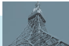
東京タワーにアンテナ・給電線を設置
