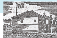
本所鋳銅所、山田電線製造所の開設
