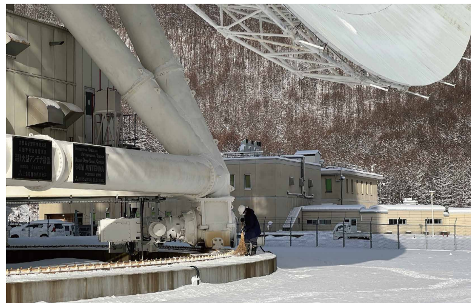
白田局のレールに積もった雪を掃く所員。アンテナから水の塊が落ちてくることがあるため、ヘルメットを被っている。
