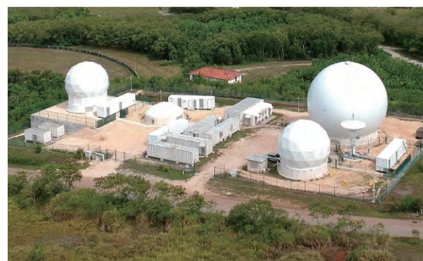
2基のアンテナを追加設置したグアの追尾局。既存の2基のアンテナも含め、互いに追尾方向を遮蔽してしまう懸念があり設置場所に工夫を要した。
