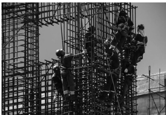
Construção da usina hidrelétrica de Jirau. Porto Velho (RO).
