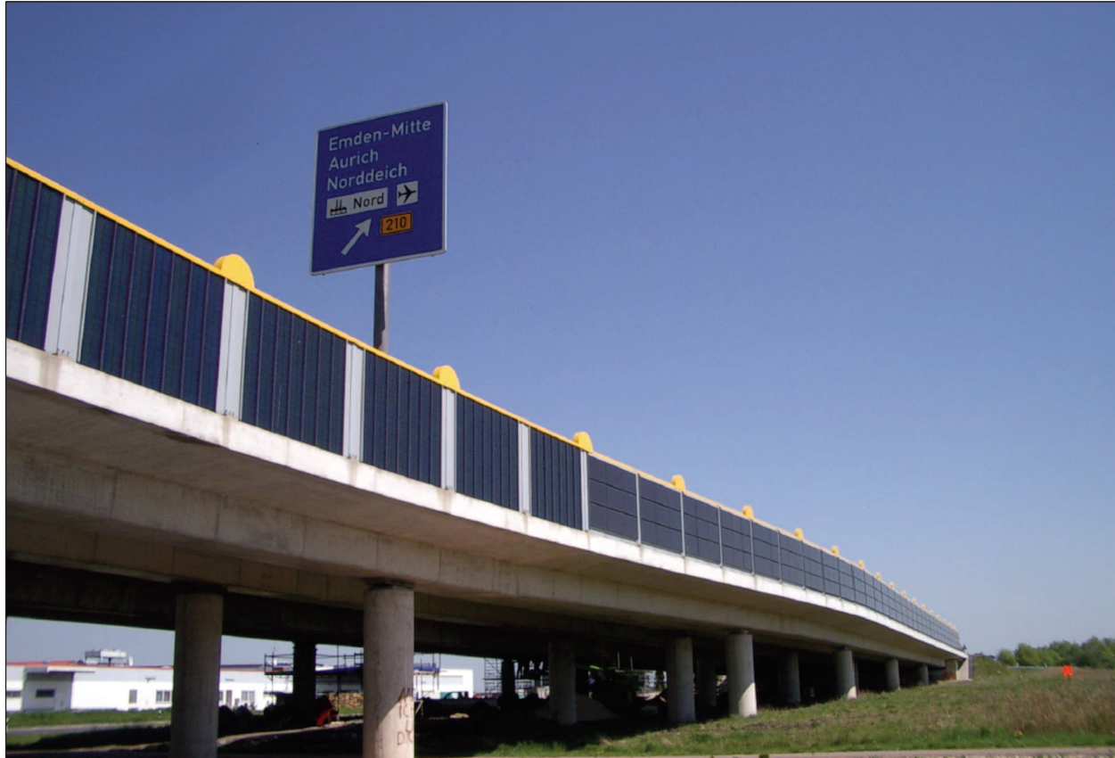
Bild 4: Senkrecht angebrachte PV-Module an einer Brücke der A 31 bei Emden (Quelle: AG Lärmschutz – jetzt)
