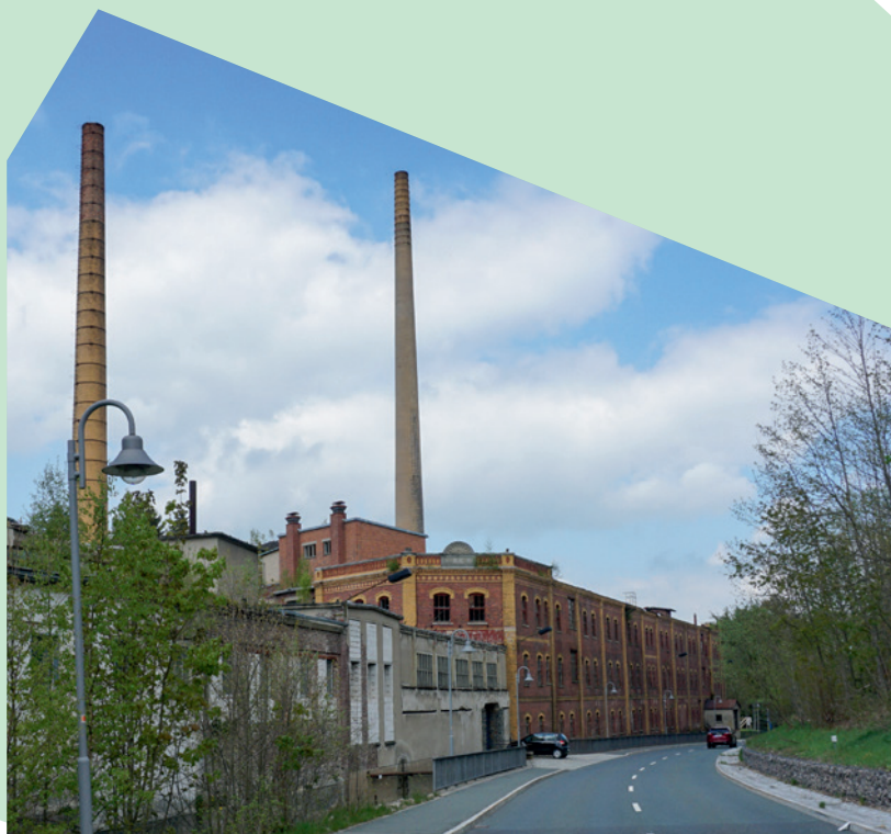
Ehem. Lederfabrik Keffel • Tannenbergsthal (2020)
