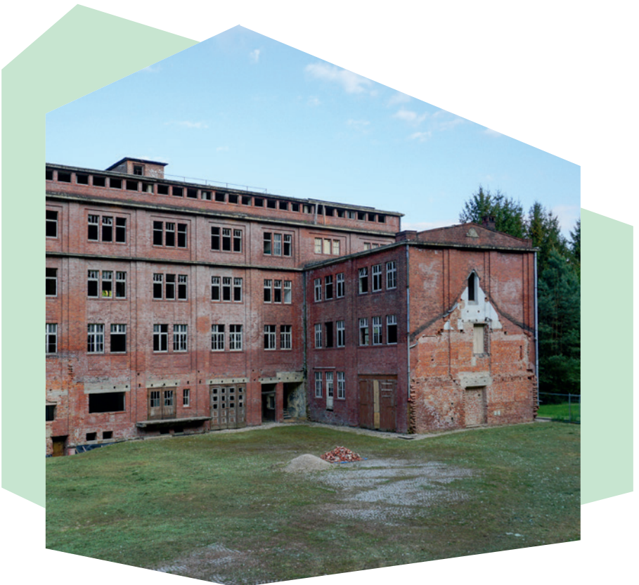
Ehem. Textilfabrik Ernst Engländer • Berga (2020)
