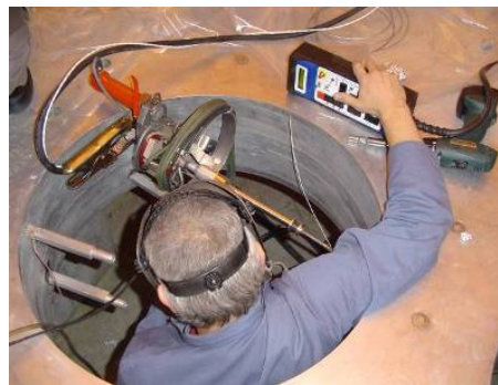
Figure 2 : Soudage TIG orbital de jonctions bimétalliques aluminium/inox
