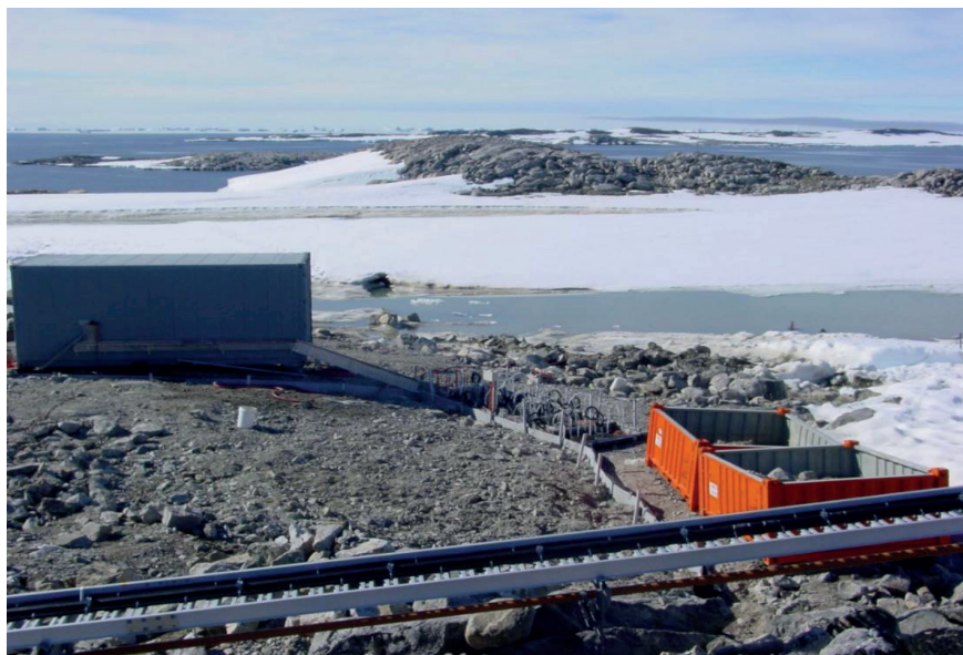
Photo 3 : Ailettes et porte remblayées.
