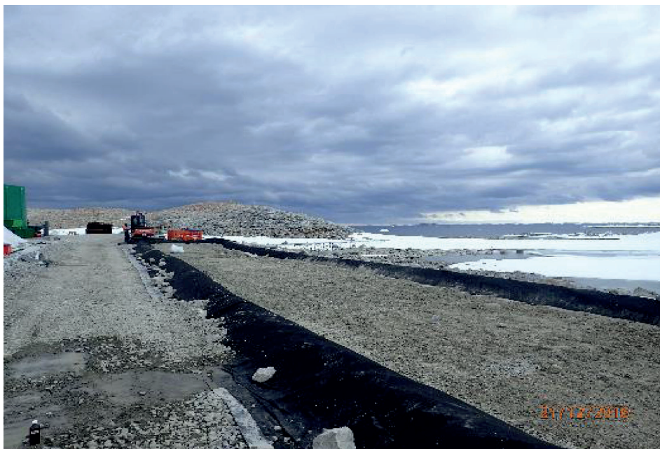
Photo 5 : Couche de protection de terre plus fine placée dans la zone de confinement du bioterre.
