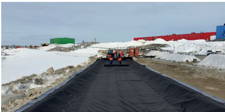
Photo 4 : Construction achevée du système de revêtement composite, avec le géotextile (noir) recouvrant la géomembrane (noire/grise) et le géosynthétique bentonitique au-dessous.
