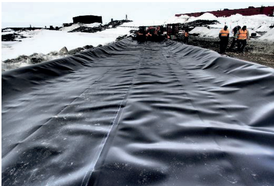
Photo 3 : Géomembrane (noire) placée sur le géosynthétique bentonitique et les bermes. Observez le joint soudé à chaud qui traverse le centre de la géomembrane et qui relie deux panneaux.
