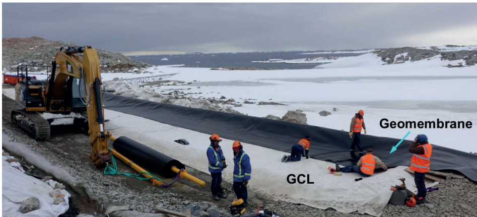
Photo 2 : Installation du géosynthétique bentonitique (GCL, blanc) et de la géomembrane (noire).
