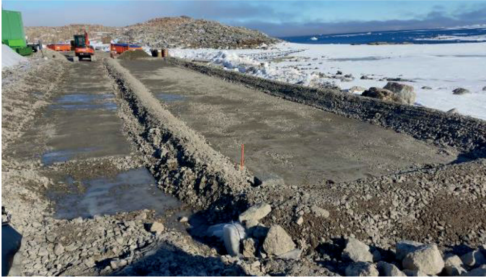
Photo 1 : Sol de fondation tassé du bioterre, avec des bermes en terre, avant l'installation des autres composantes du système de revêtement composite (géosynthétique bentonitique, géomembrane et géotextile).
