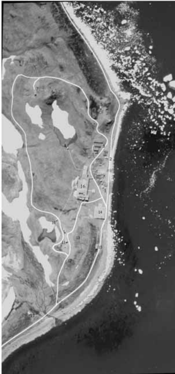
Figura 5B: Zonas de instalaciones de la Estación Comandante Ferraz.
