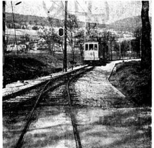
Arrivée en gare de Colombier. A gauche du poteau, devant le tram, on distingue la plaque noire du signal de sécurité annonçant la voie libre entre les deux stations de Colombier et d'Auvernier.
