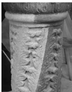
Čišćenje pojedinih delova kamenog stuba crkve Stavropoleos
