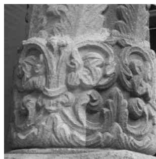
Čišćenje pojedinih delova kamenog stuba crkve Stavropoleos
