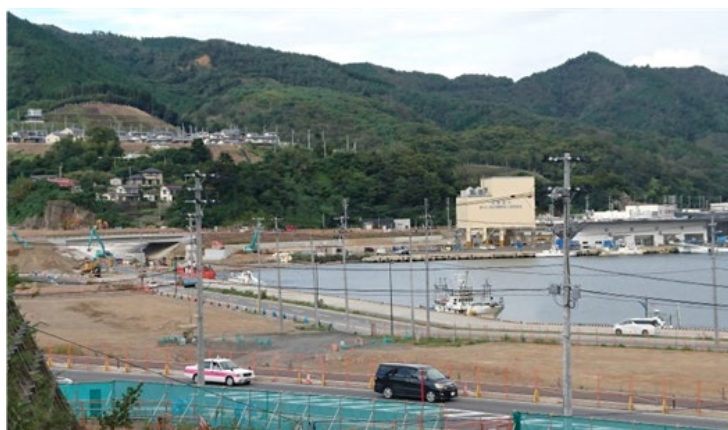
写真 1. 公園整備工事が続く女川港付近。左上の高台に造成された大規模住宅地が見える=2018 年 9 月 17 日
