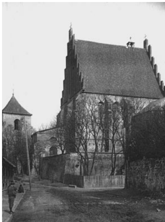
Kościół po zniszczeniach w 1914 r. – bez wieżyczki na sygnaturkę i kopuły nad kruchtą (Zakład Architektury Polskiej Politechniki Warszawskiej)
