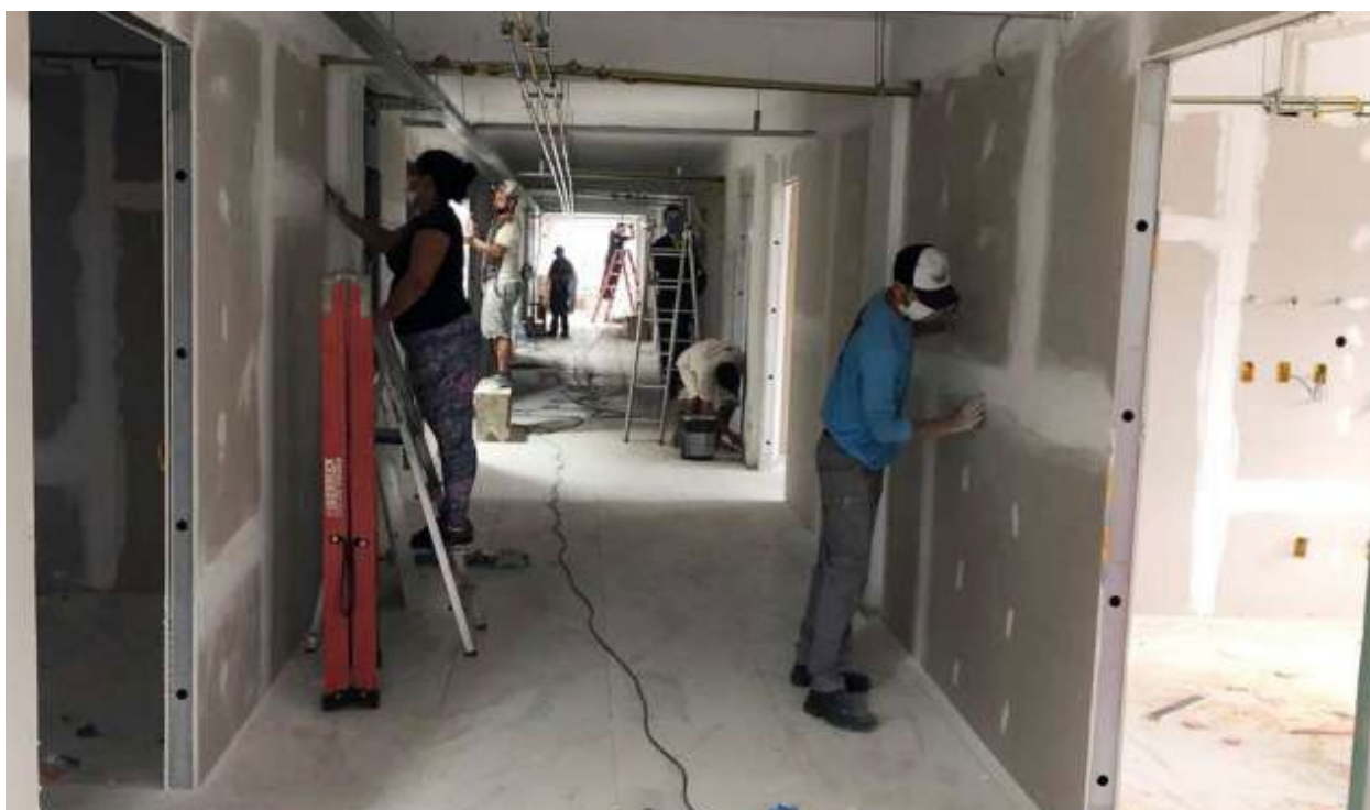
Para ampliar a capacidade de enfrentamento à covid-19, o CIC-BG lidera uma campanha de arrecadação de recursos com a comunidade. Os valores chegam a quase R$ 700 mil e financiam diversas ações, entre elas a construção de 40 leitos na UPA
