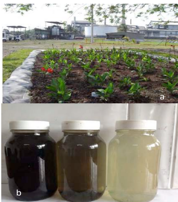
Figura 3.8. a.-Humedal artificial para el tratamiento de las aguas residuales de un ingenio azucarero; b.-muestras de agua del ingenio antes y después del sistema de tratamiento basado en humedales artificiales.
