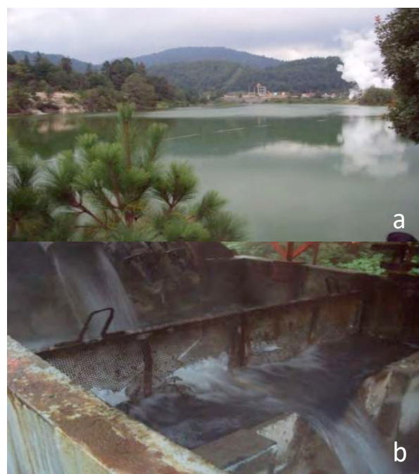
Figura 5.7. a.- Laguna Verde dentro de la planta geotérmica “Los Azufres”; laguna artificial con agua para inyección al subsuelo. Las comunidades de ZIT y SPJ son las más cercanas a esta área. b.- Contenedor metálico para sólidos gruesos presentes en el agua de inyección, ésta es producto de la condensación del exceso de vapor y es muy corrosiva.
