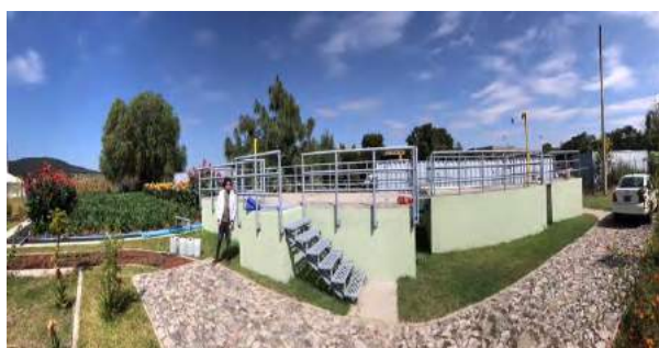
Figura 3.1. Perspectiva de la PTARD-SEE en la sede de CIATEJ-Zapopan. En primer plano se aprecian las instalaciones del tanque séptico y el filtro anaerobio, y a la izquierda el humedal artificial subsuperficial.
