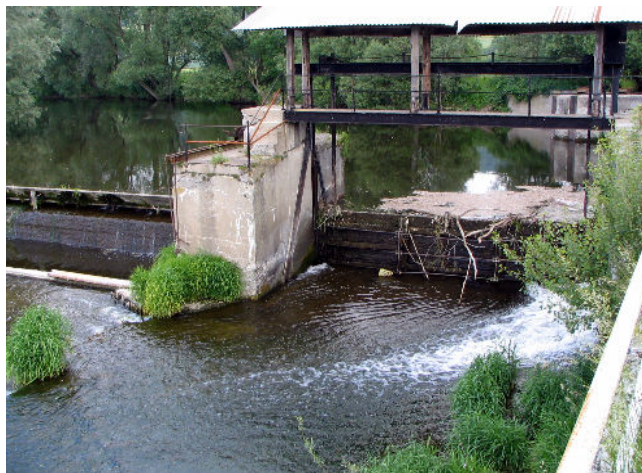
Abb. 20: Ein Wehr zur Ausleitung von Wasser für ein Kleinwasserkraftwerk. Die Autoren und Autorinnen dieser Roten Liste unterstützen den Ausbau nachhaltiger Energiegewinnung in Deutschland. Gewässer sollten dabei aber nicht durch Kleinwasserkraftwerke zur Gewinnung vernachlässigbar kleiner Energiemengen zerstört werden. (Foto: Falko Wagner)
