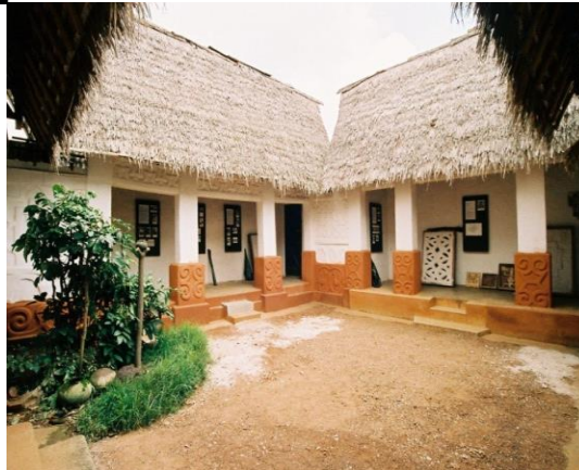
Bâtiments traditionnels Asante – Ghana ©FPMA
