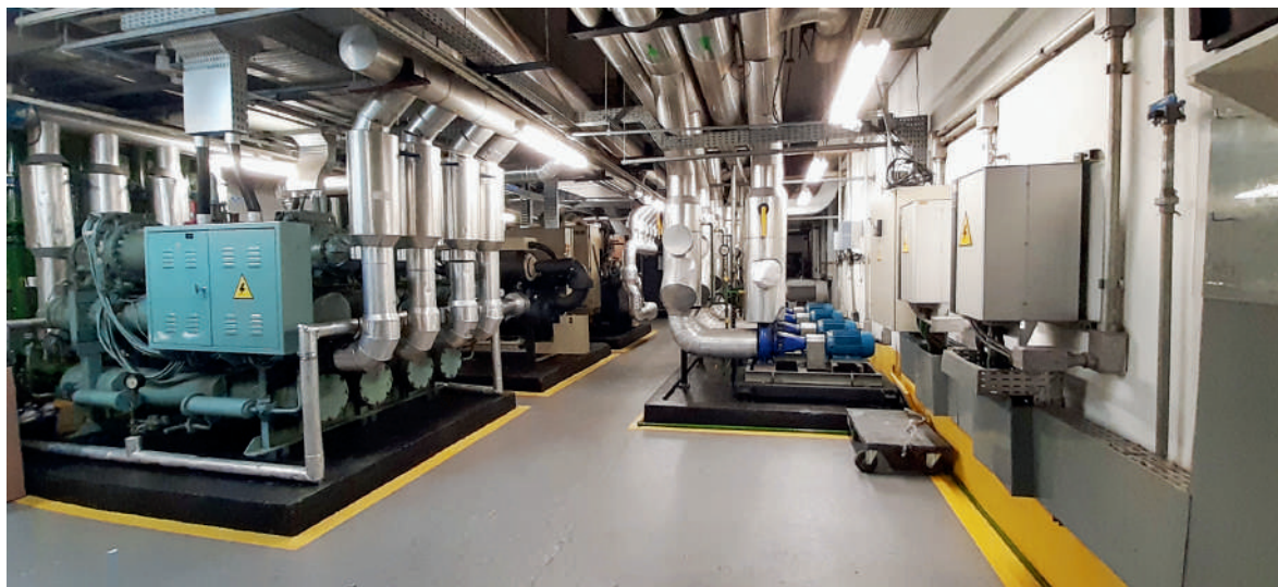
Central de Água Gelada após instalação do Chiller 175TR
