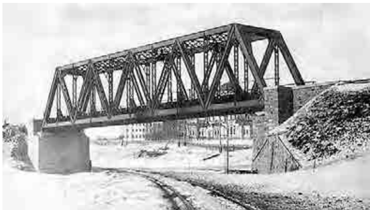
Мост Алтайской железной дороги, мост через сибирский путь
