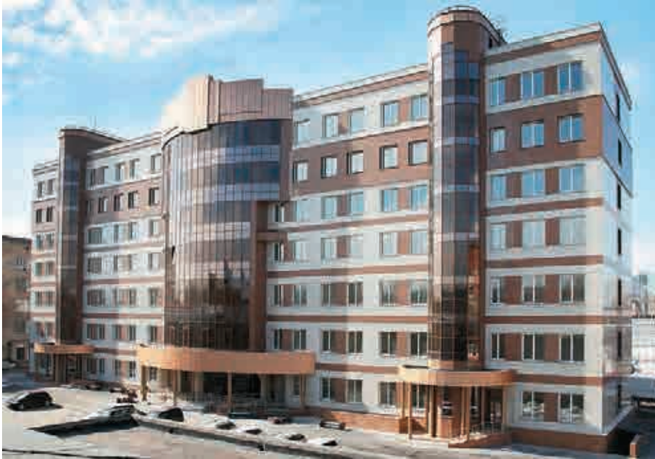
Новый корпус НГТУ
