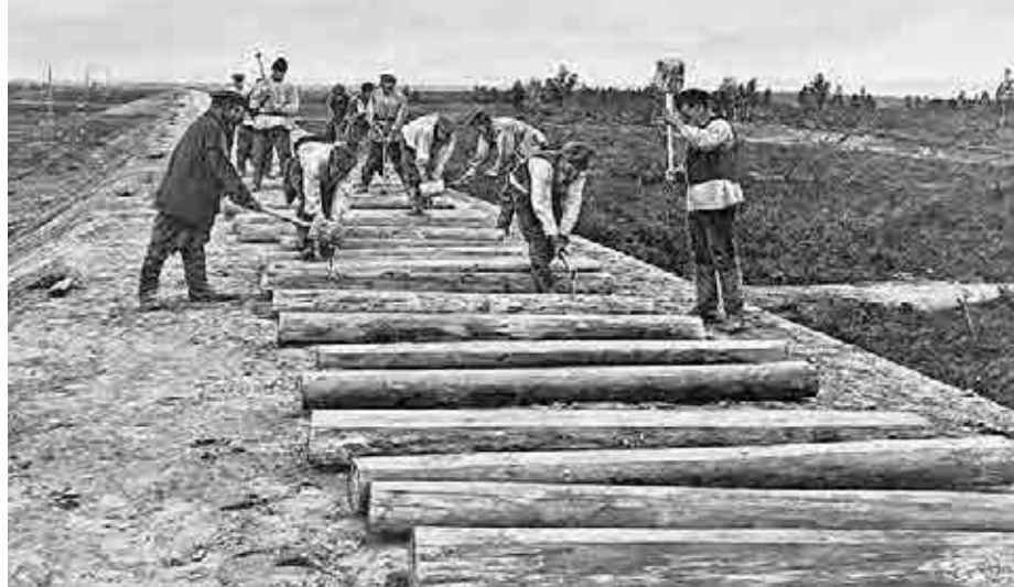
Укладка шпал на Транссибирской железнодорожной магистральной, 1896 г.
