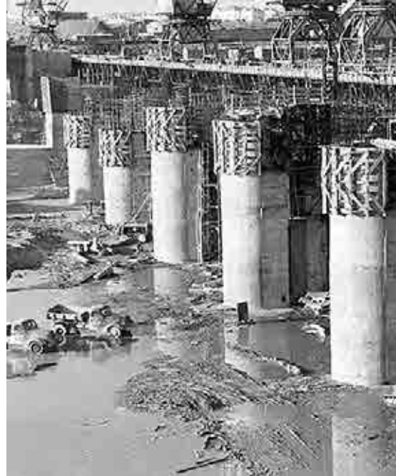
Строительство Новосибирской ГЭС
